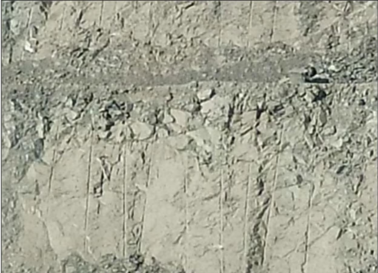
*Foto 18: Vista de los taladros Pre-Corte después de un perfilado con equipos.*
