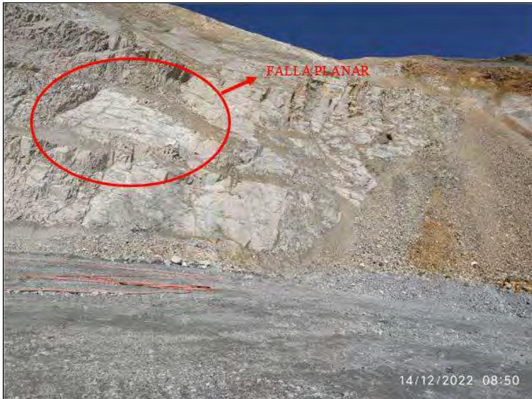
Foto 6: Vista del área del deslizamiento de una falla planar.
