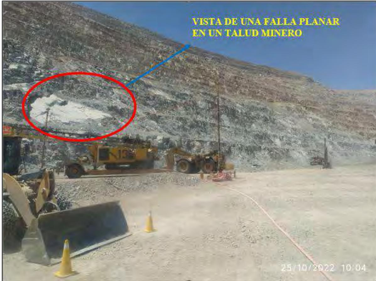
*Foto 7: Formación de una falla planar en un banco de un talud minero.*
