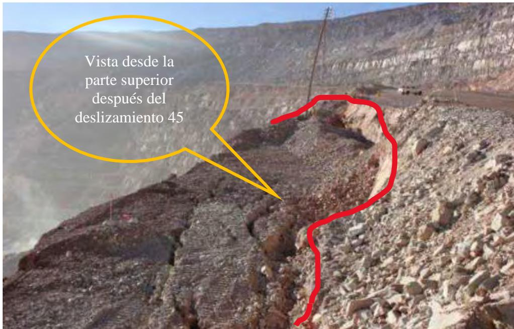
*Foto 3: Escarpe derecho generado por el deslizamiento D45.*
