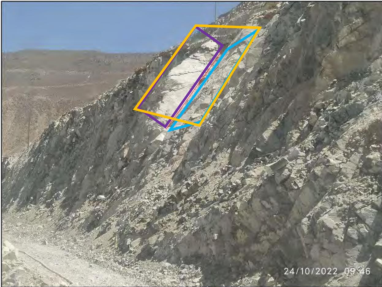
**Foto 9:** Vista de una formación de una falla en cuña en un talud minero al Sur-Oeste de la fase 6B2.
