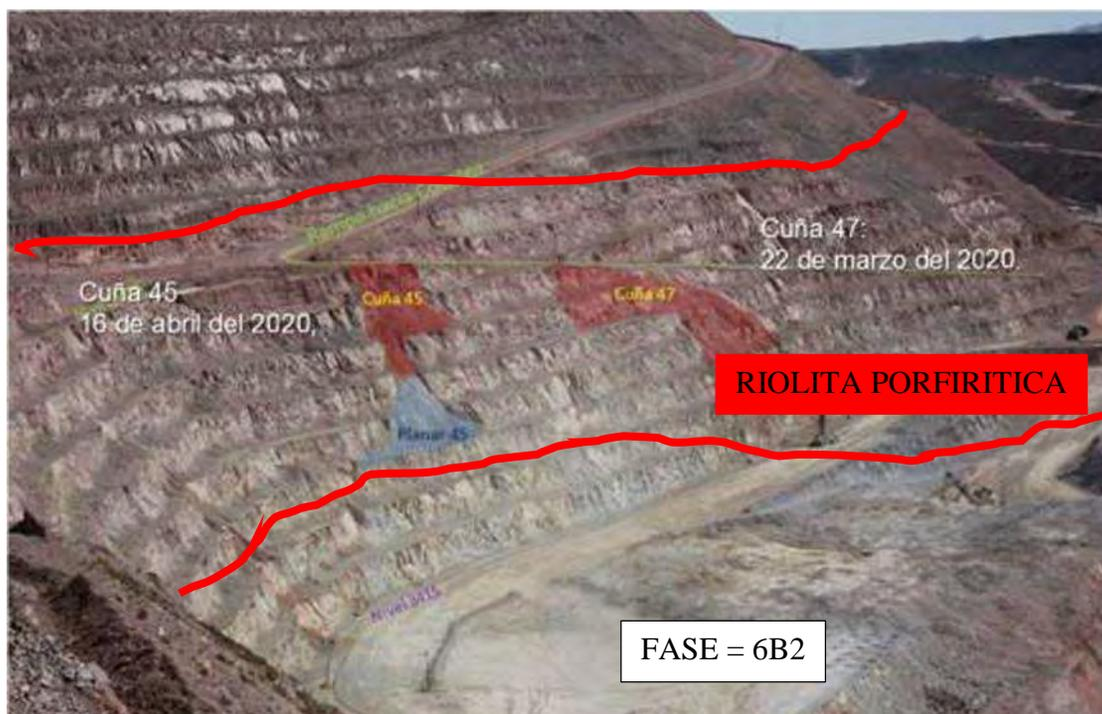
Foto 4: Vista panorámica del deslizamiento D45 y D47 al Sur-Oeste del Tajo Cujone.
