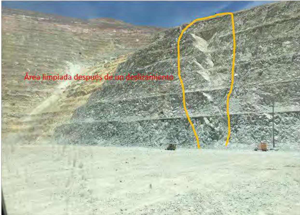
*Foto 16: Vista de cómo queda después de hacer limpieza del material deslizado*
