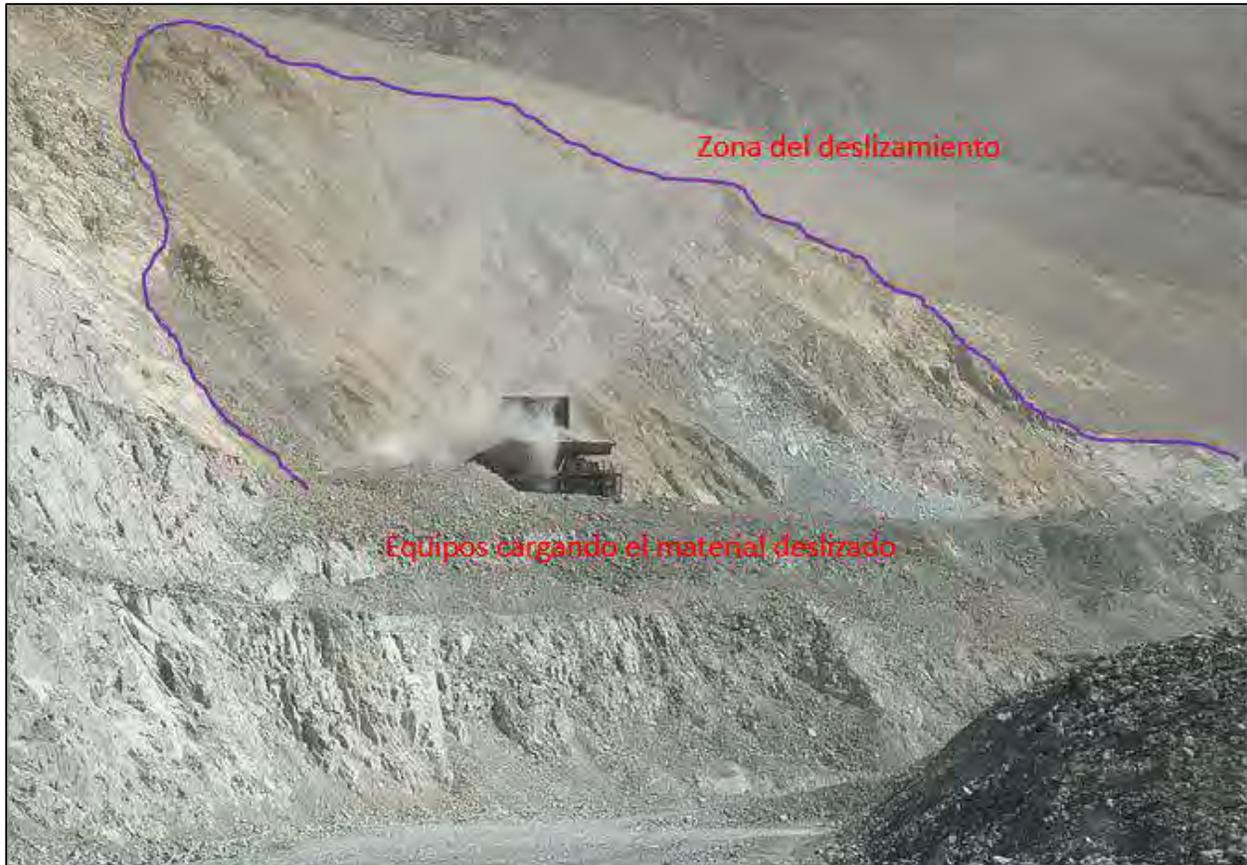
*Foto 14:* Vista de cómo se retira el material desplazado en el deslizamiento una vez estabilizado con equipos.
