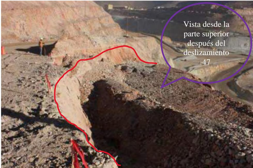
**Foto 2:** Escarpe izquierdo generado por el deslizamiento D47.
