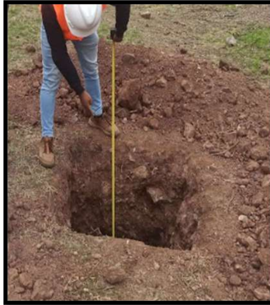
Imagen N° 30: Apertura de calicatas de 1.5x1.5x2.0, con ayuda de herramientas manuales Fuente: Elaboración Propia
