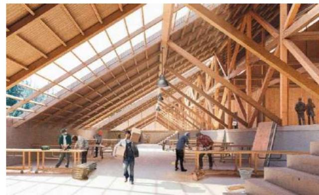
Figura 37 Uso de la estructural de madera en cubiertas en el área de talleres
