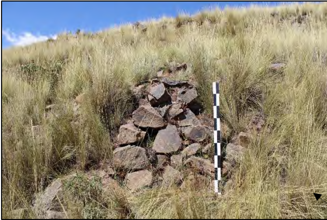
Muro de contención de aparejo rústico
