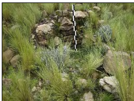
Muro de aparejo rústicó
