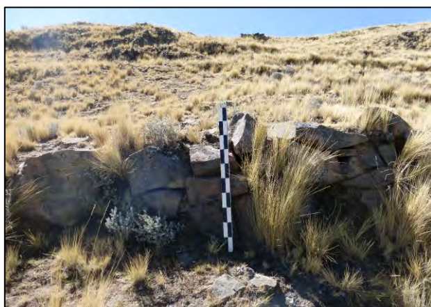
Vista de la sección Suroeste de la muralla III
