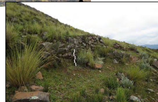
Muro de contención con altura de 1.00 m.
