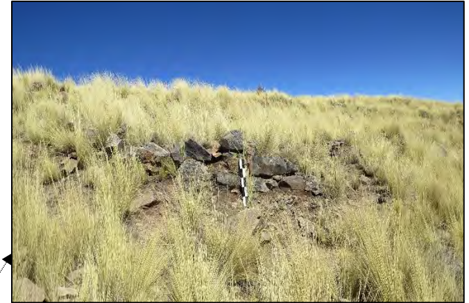
Muro de contención construido con piedras de arenisca feldespática y cuarzosa.
