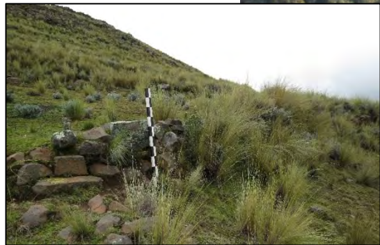
Muro de contención que sostiene el camino.
