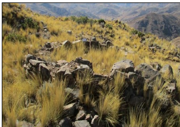
Muro de estructura grande colapsada
