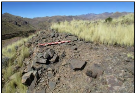
Muro de contención VI
