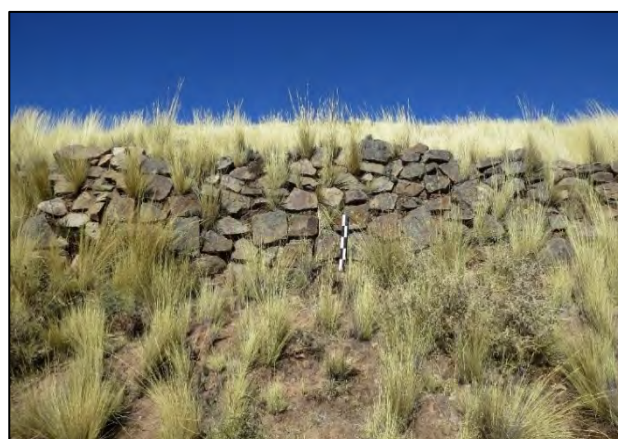
Vista de la sección Norte de la muralla I.
