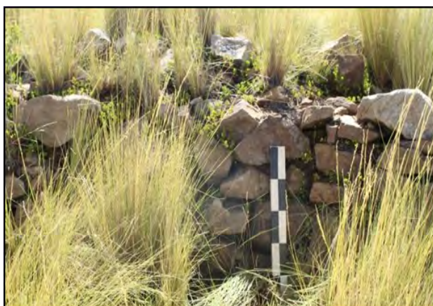
Muro de contención de aparejo rustico
