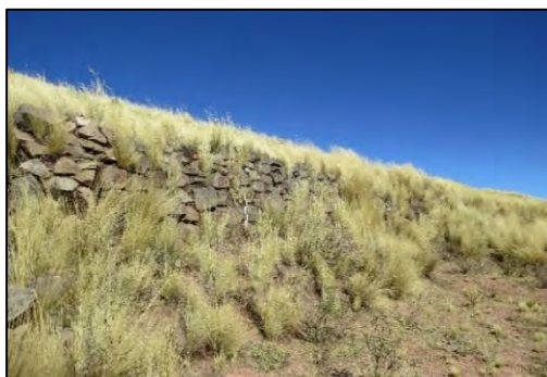
Sección Noreste de muro de la Muralla I
