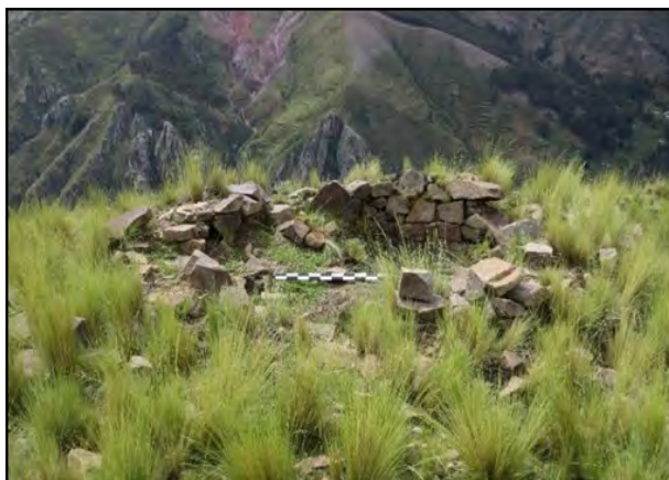
Estructura de planta circular en mal estado de conservación
