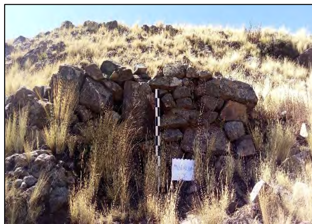
Vista de la sección Noreste de la Muralla III
