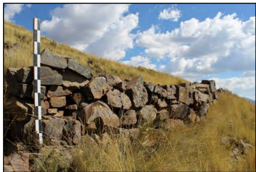
Sección de muro de la Muralla II
