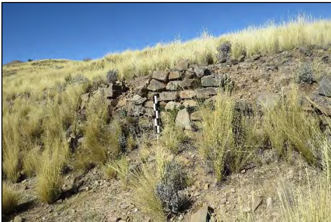
Muro de contención adosado a afloramiento rocoso.
