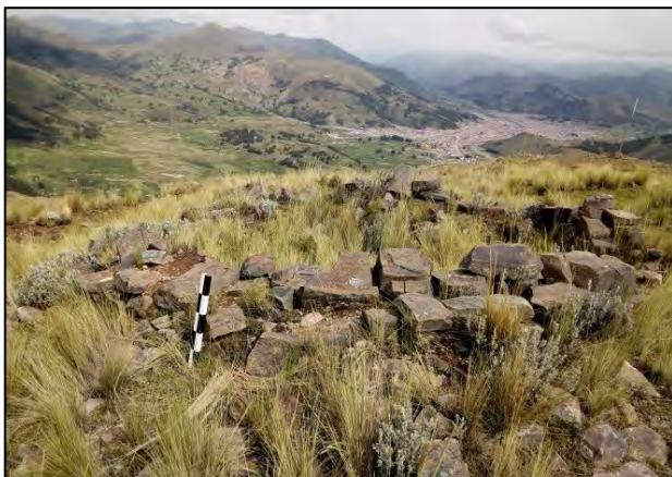
Muro de estructura grande colapsada.
