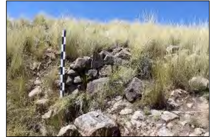
Muro de contención adosado a afloramiento rocoso.
