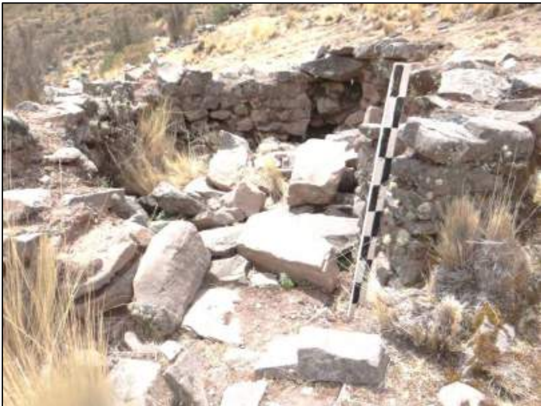
Figura 101 Vano de acceso de la estructura circular EC49-P
