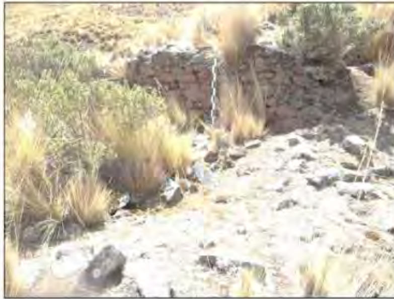
vista de la sección externa de estructura
