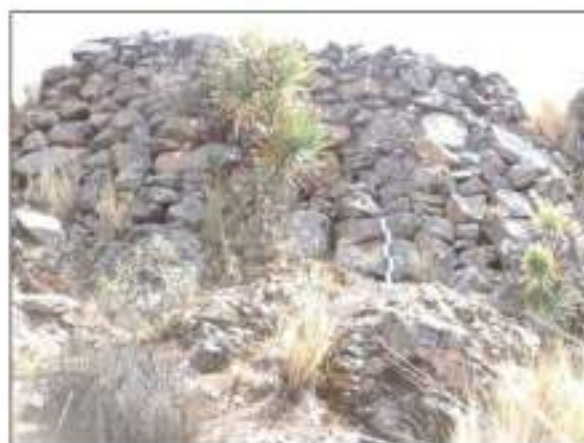
vista del segmento de muro de contención n° 5
