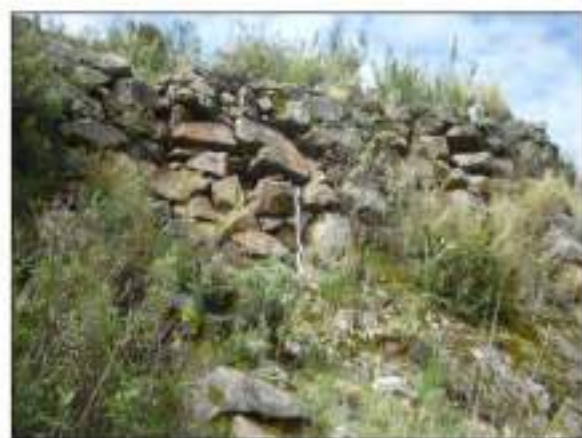
vista del segmento de muro de contención n° 4
