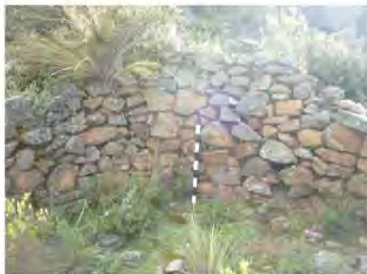
vista del interior de estructura circular
