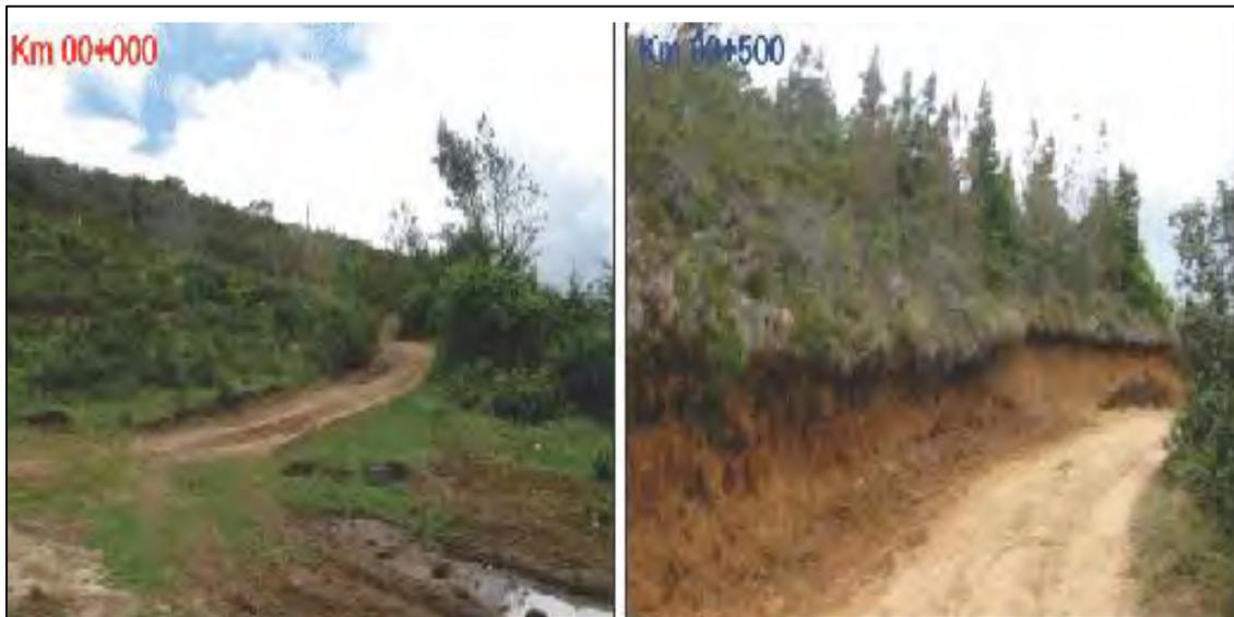
Fotografía 37. Tramo Atunloma – Congona, Km 00+000 AL Km 00+500, Inicio del tramo Atunloma- Congona donde se aprecia material deposito coluvial compuesto de limos y arcilla.
