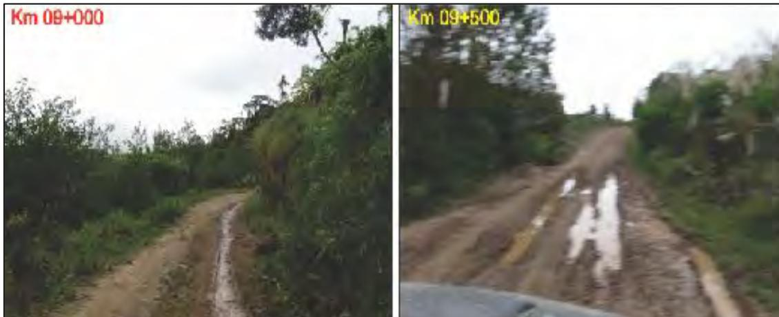
*Fotografía 31. Tramo Empalme LA\_103 – Mamagpampa, Km 09+000 AL Km 09+500, en cuanto a la litoestratigrafía se aprecia limonita de grano fino cubierta por material coluvial compuesta de gravas, limos y arena.*
