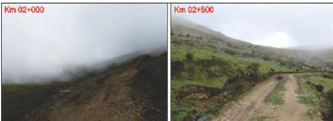
Fotografía 24. Tramo Empalme LA\_103 – Mamagpampa, Km 02+000 AL Km 02+500, en cuanto a la litoestratigrafía se aprecia limonita de grano fino cubierta por material coluvial compuesta de gravas, limos y arena, en sectores se aprecia interestratificación de arenisca.
