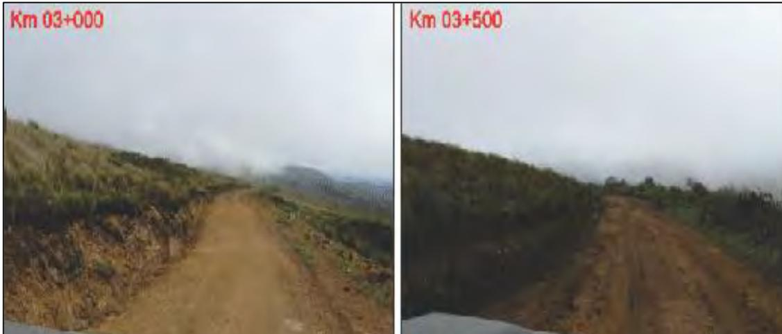
Fotografía 25. Tramo Empalme LA\_103 – Mamagpampa, Km 03+000 AL Km 03+500 , A lo largo del tramo km 03+00 a km 03+500 se aprecia material volcánico andesítico generalmente en los primeros tramos de la vía.
