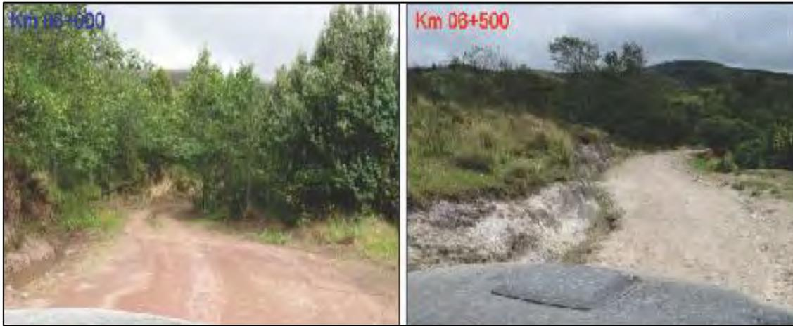
Fotografía 28. Tramo Empalme LA\_103 – Mamagpampa, Km 06+000 AL Km 06+500, Vista panorámica del km 06+00 donde se aprecia depósitos coluviales cubriendo, limonita con gravas.
