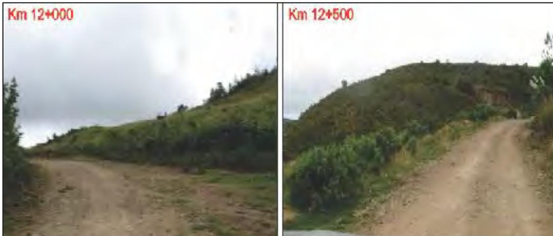
Fotografía 34. Tramo Empalme LA\_103 – Mamagpampa, Km 12+000 AL Km 12+500, en este tramo se observa deposito coluvial compuesto de limos y arcilla.
