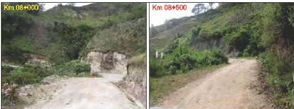
Fotografía 30. Tramo Empalme LA\_103 – Mamagpampa, Km 08+000 AL Km 08+500, en este tramo carretero se observa conglomerados con elementos volcánicos, intercalados con aglomerados andesíticos.
