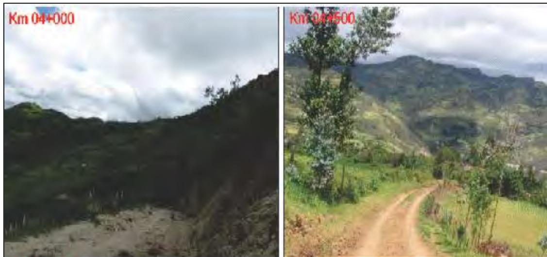
*Fotografía 41. Tramo Atunloma – Congona, Km 04+000 AL Km 04+500, en este tramo en km 04+00 tiene un pendiente pronunciado, con desprendimiento de material coluvial de gravas y limo arenoso.*
