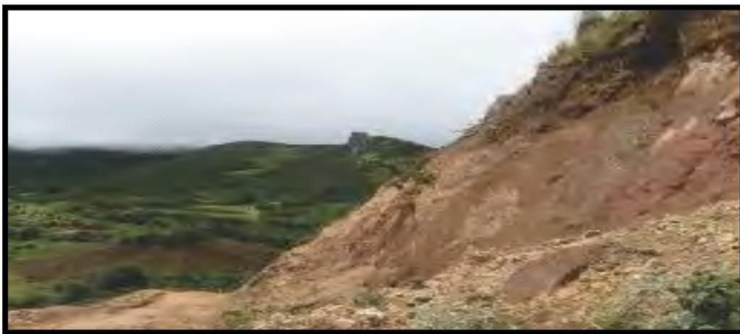
*Fotografía 21. Talud de corte de la vía, que se ha desarrollado sobre un depósito coluvio-aluvial, constituido por un agregado de grava en una matriz fina conformada por limo arenoso con contenido subordinado de arcilla.*
