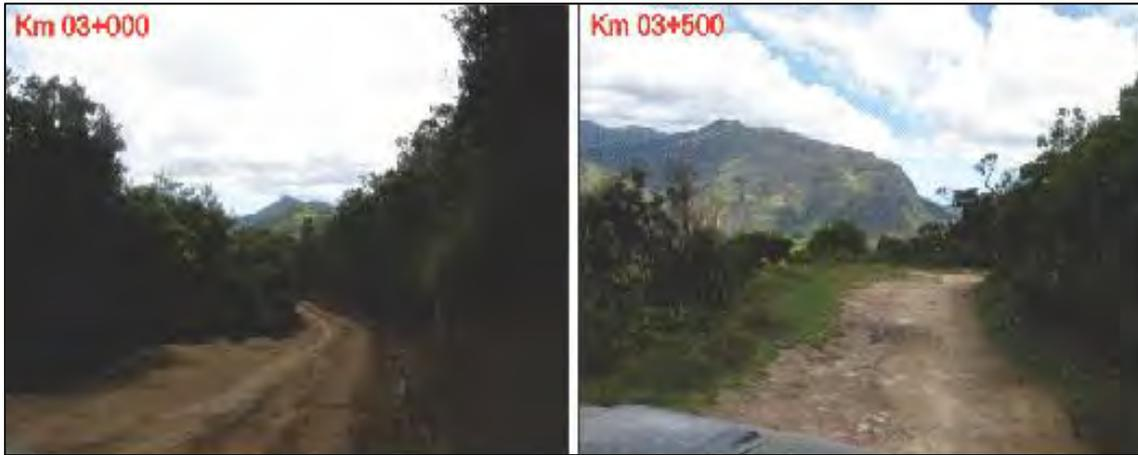
*Fotografía 40. Tramo Atunloma – Congona, Km 03+000 AL Km 03+500, en el tramo carretero se observa material coluvial de limo arenoso.*
