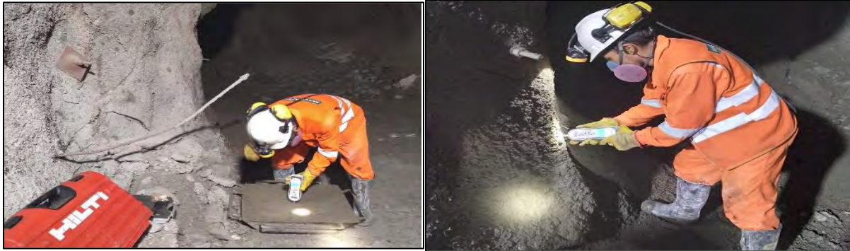
Figura 56 Ensayo con penetrómetro digital.
