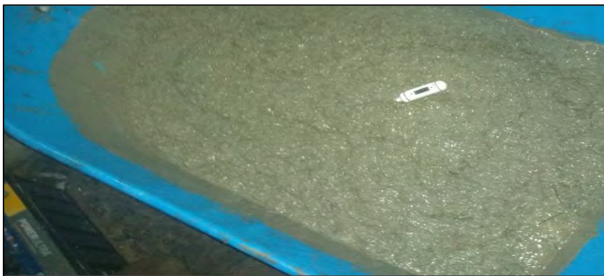
Figura 47 Control de temperatura de shotcrete
