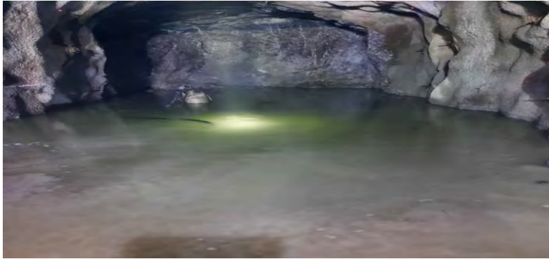
Figura 25 Presencia de agua en el macizo rocoso y empozamiento en Rp565
