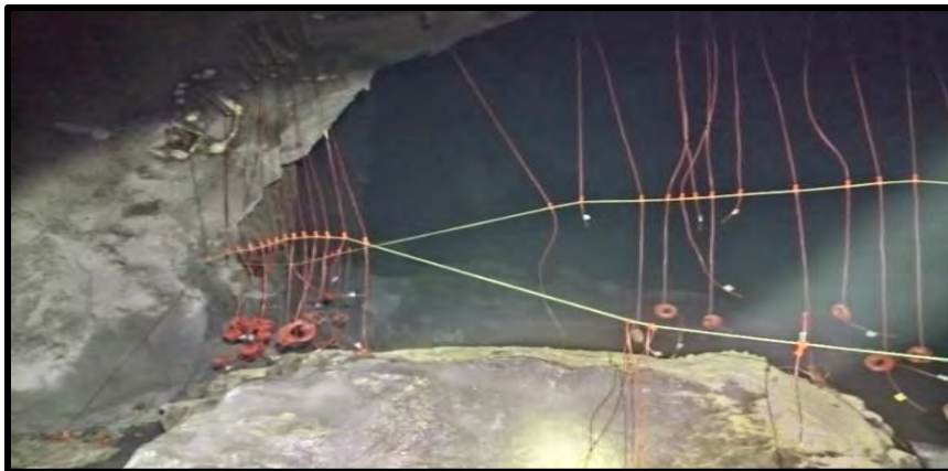
Figura 32 Se observa una sección de taladro positivos cargados
