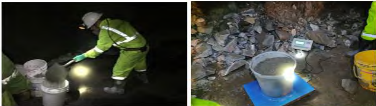
Figura 61 Manta para recolectar el rebote del shotcrete.
