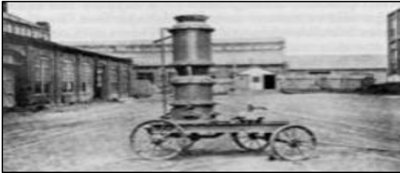
Figura 1 Equipo de shotcrete en 1907
