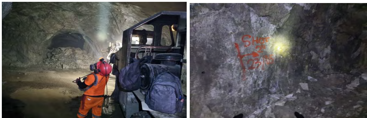
Figura 42 Preparación y posicionamiento de equipo Alpha 20
