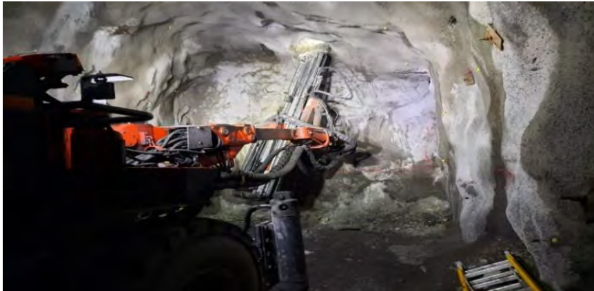
Figura 33 Inyección de perno helicoidal con equipo jumbo retracktril.
