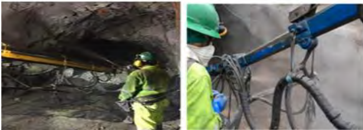
Figura 60 Lanzado de shotcrete en la rampa principal del nivel 23
