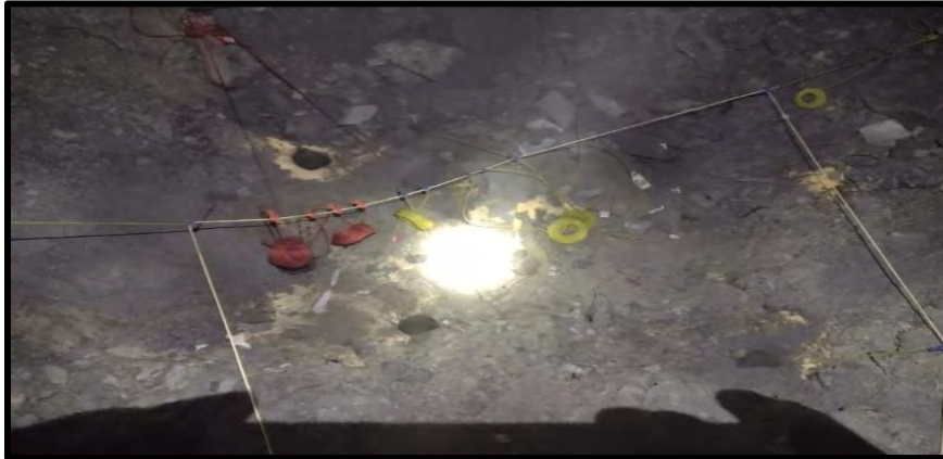
Figura 31 Se observa la malla de perforación cargado de VCR
