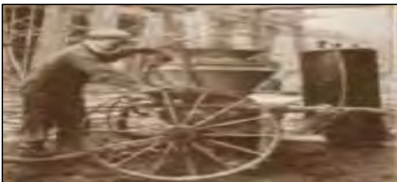
Figura 2 Equipo de shotcrete en 1920
