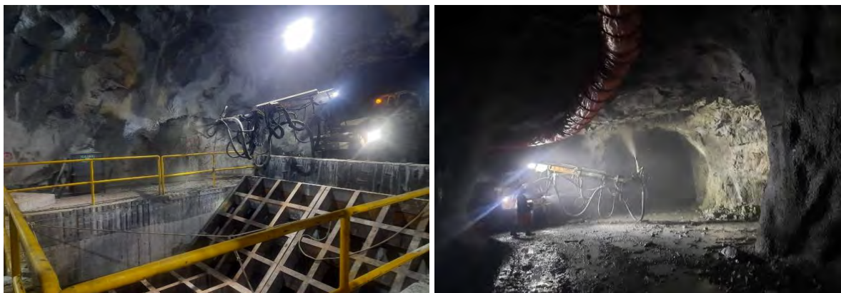
Figura 3 Shotcrete sostenimiento pasivo de rompe banco y pilar del tajo 445 nv.18.
