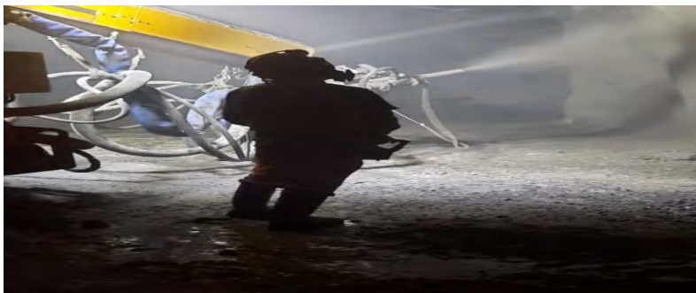
Figura 55 Equipo putzmeister SPM. 4210 lanzando con fibra sintética
