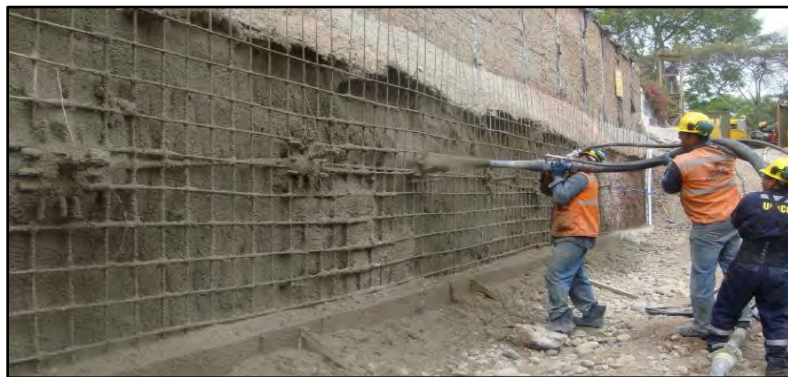
Figura 9 Aplicación de shotcrete con refuerzo de malla
