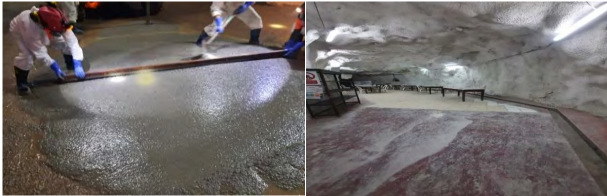
Figura 4 Concreto vaciado en obras civiles de mejoramiento de comedor nv. 14.
