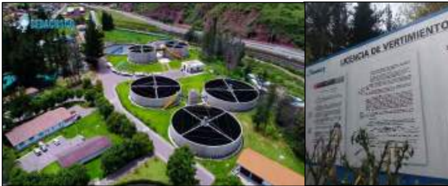
Planta de Tratamiento de Aguas Residuales de San Jerónimo
