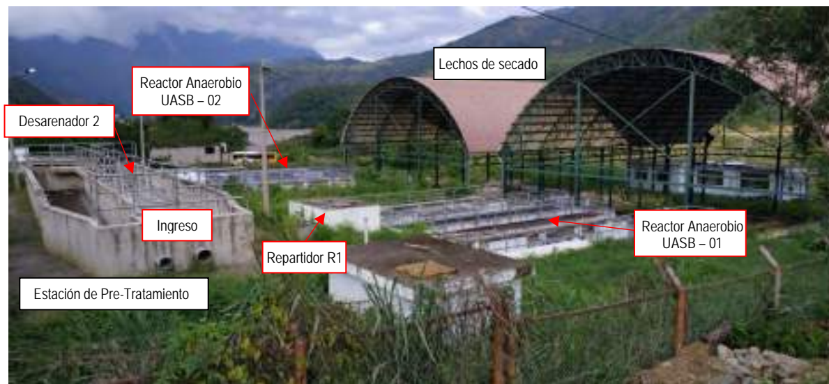
Planta de Tratamiento de Aguas Residuales de Chaquimayo
