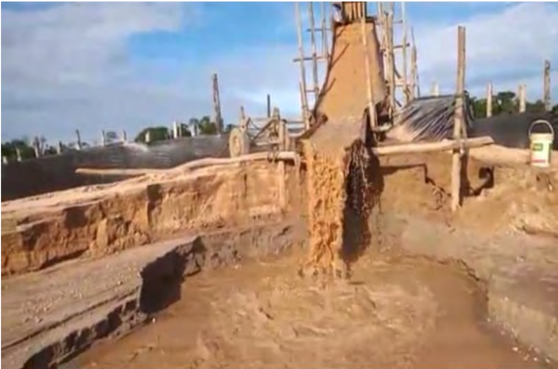
Imagen 24: Tolva y accesorios dentro de la concesión Linda Dos
