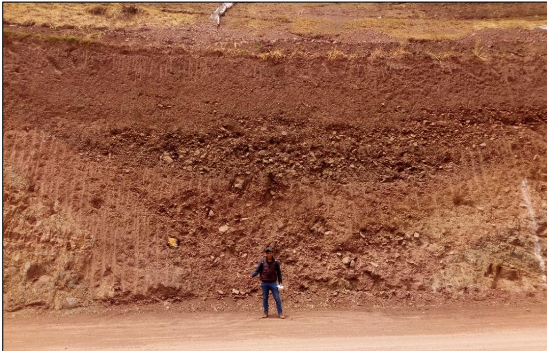
Fotografía 14. Se puede apreciar material coluvial de relleno en antiguas quebradas en la APV Hatun Wasi en el corte de carretera.
