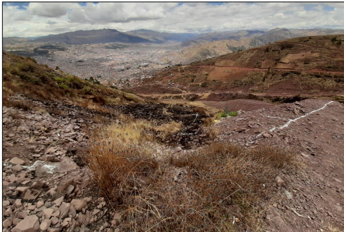
Fotografía 15. Presencia de erosión de laderas en la APV San Bernardo.
