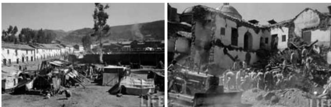
Fotografía 10 A y 10 B. Terremoto de mayo de 1950 en Templo Sagrado de Santo Domingo y Compañía de Jesús respectivamente. Fuente: Escenario de Riesgo Sísmico y Movimiento en masa Producido por la Reactivación de la falla Tambomachay, Provincia del Cusco - INDECI, 2015, p. 27
