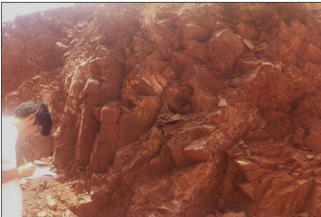
Fotografía 5. Areniscas fluviales con estratificación contraria a la pendiente en el corte de carretera de la APV Hatun Wasi.
