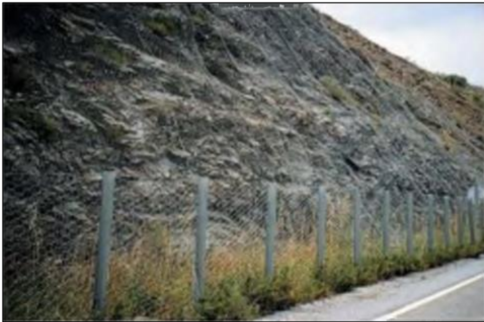
Figura 26. Protección superficial de taludes con mallas metálicas para evitar caída de roca. González L. (2002)
