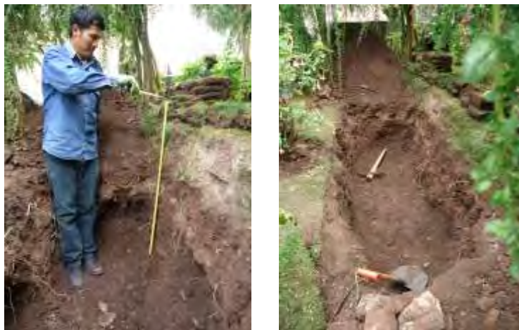
Fotos 71-72. Pozo de excavación con 90 cm de profundidad.
