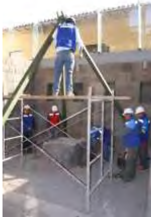
Fotografía 56. Instalación de tecele de tres toneladas de capacidad.
