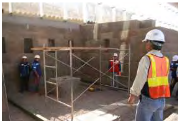
Fotografía 55. Instalación de andamios para acondicionar el trípode metálico.
