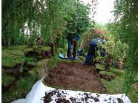
Foto N°74. Pozo de excavación relleno y reposición del césped.
