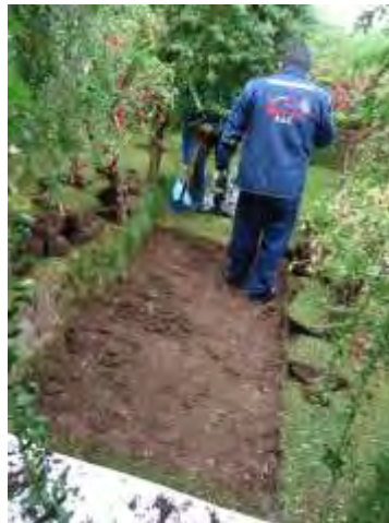
Foto N°70. Retiro del césped para excavar.
