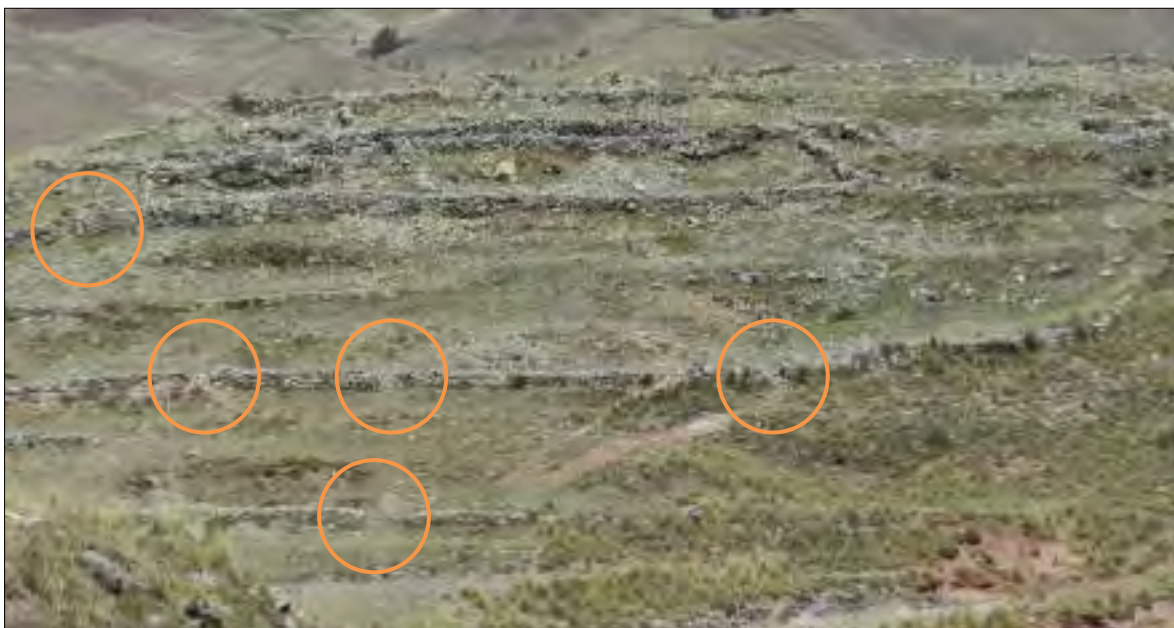
Imagen 38. Vista de los posibles accesos al sector “A”, los que han sido alterados dificultando su identificación. Fuente: Propia.
