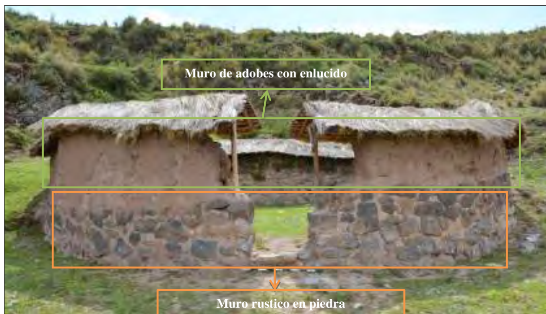
Imagen 32. Vista frontal del recinto N°27 donde se aprecia la unión del muro rústico y el muro en adobe. Fuente: Propia.
