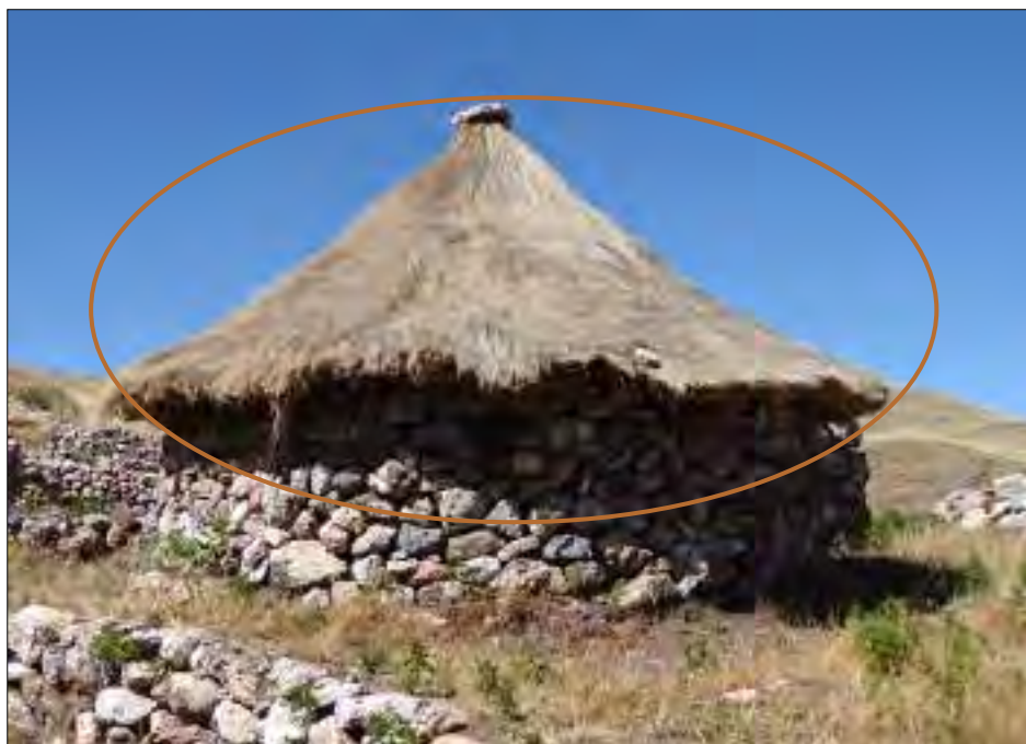
Imagen 41. Cubierta tipo choza, con columna central. Fuente: Qhapaq Ñan
