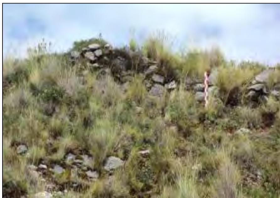
Imagen 34. Vista de un muro perimétrico de contención que se ubica en el sector B. Fuente: Propia.
