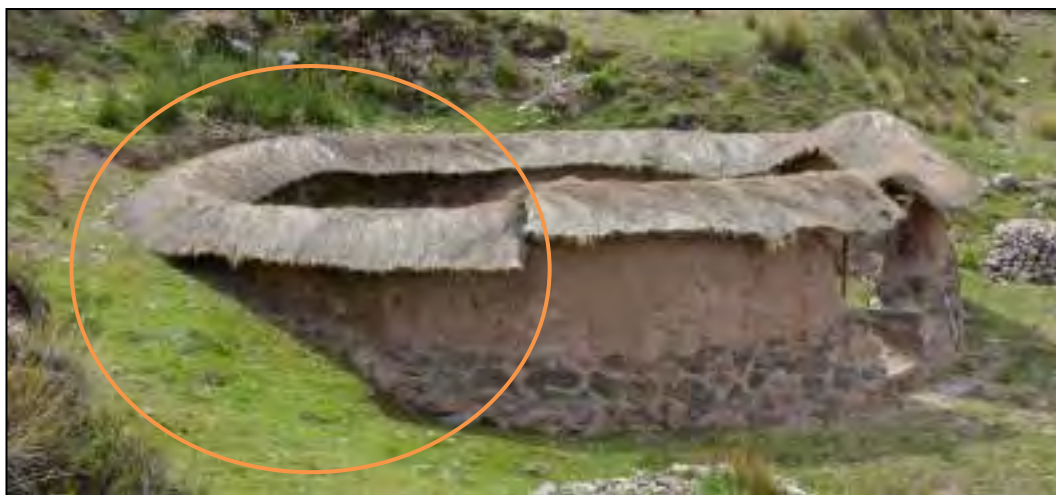
Imagen 33. Vista lateral del recinto N°27 donde se aprecia cómo se cubrió la parte posterior del muro externo. Fuente: Propia.
