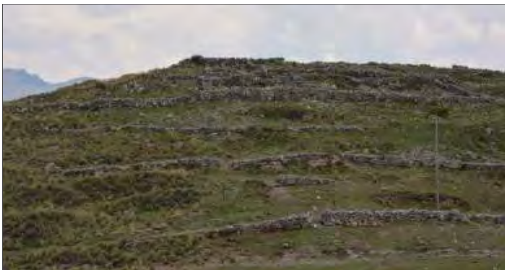
Imagen 35. Vista general del lado oeste del Sector A. en el que se puede apreciar los muros perimétricos de contención. Fuente: Propia.
