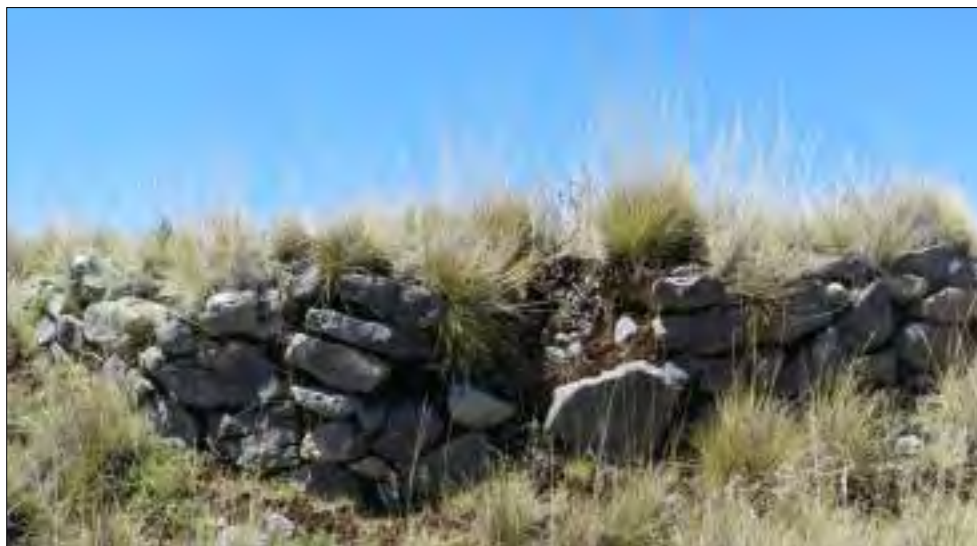
Imagen 28. Cimiento de muro perimétrico de contención, se observa los elementos líticos fueron adosados al talud de piedra. Fuente: Propia.
