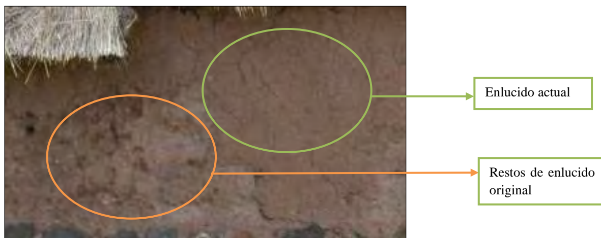
Imagen 50. Vista de comparación del enlucido en el muro de adobe del recinto N° 27. Fuente: Propia
