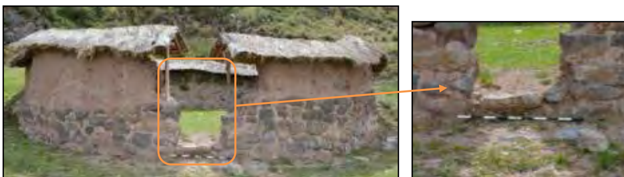
Imagen 37. Arriba vista del vano de acceso del recinto N° 27.- Derecha. - Vista a detalle del umbral del recinto 27. Fuente: Propia.
