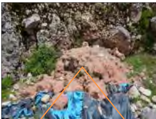
Imagen 21. Mortero en proceso de elaboración por parte de la DDC Cusco. Fuente: Propia
