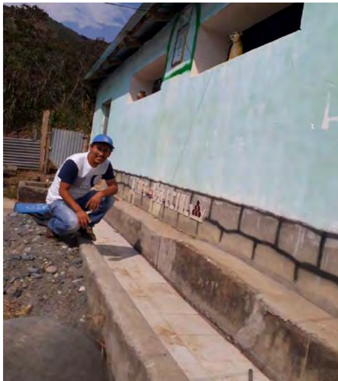
FOTO 03: Construcción de canal de correteo implementado con PROCOMPITE, Cuenca de Tunquimayo, Distrito de Quellouno, La Convención - Cusco
