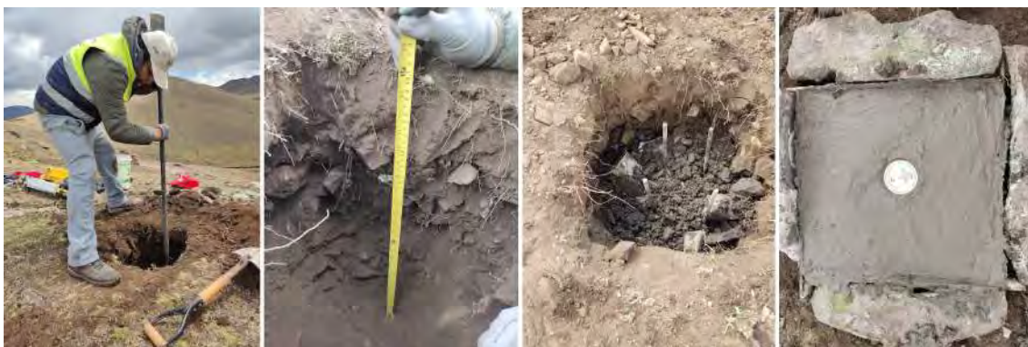
Figura 33: Proceso de monumentación del punto base
