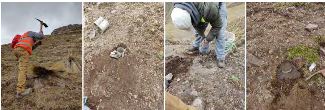
Figura 34: Proceso de monumentación de los 14 puntos restantes.
