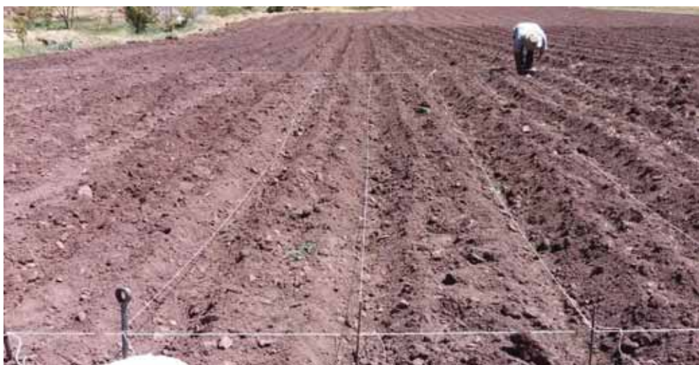
Fotografía 04. Trazo y replanteo de bloques.
