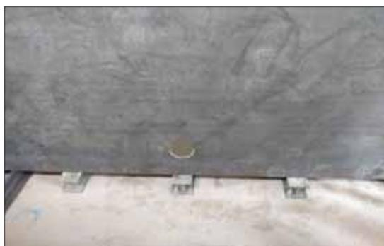
*Figura 76. Base metálica de reservorio a los pies del MAG apoyado sobre vigas*
