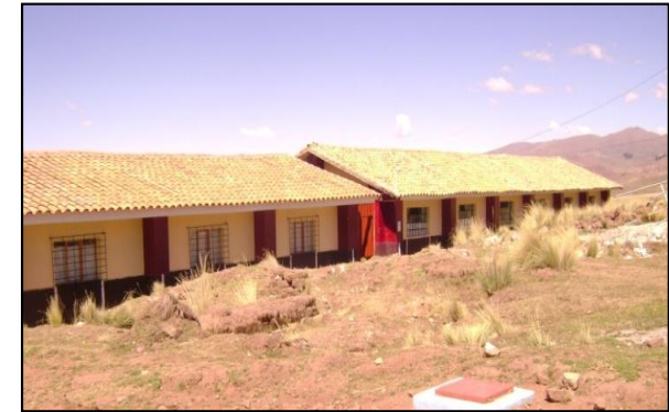
Figura N° 24: Pabellón a y b de la I.E. N° 50803
