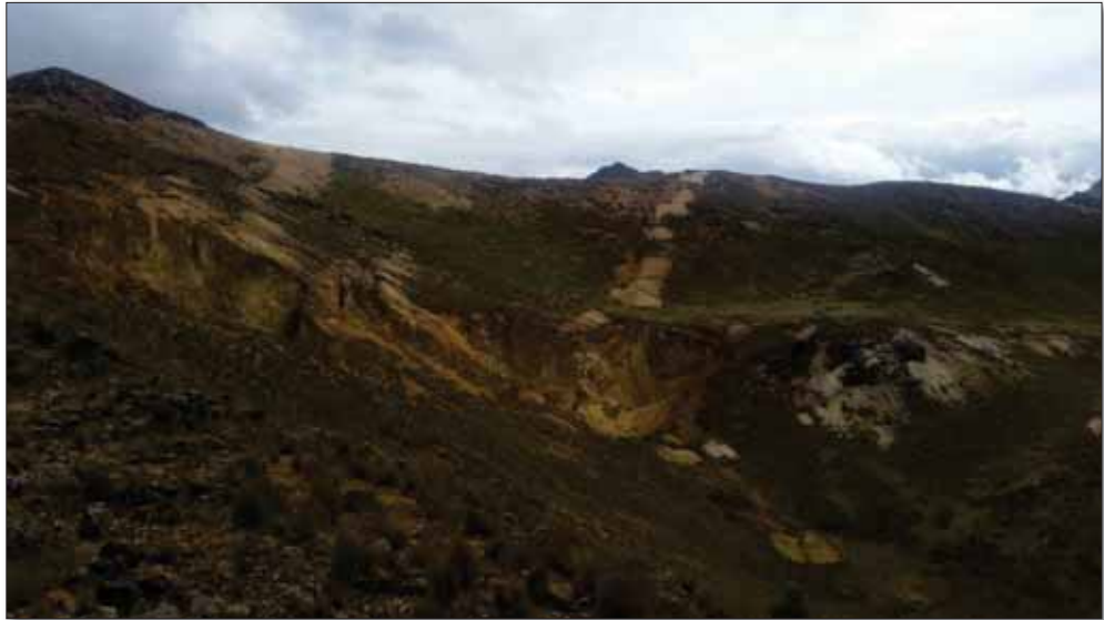
Foto N° 13: Cuerpo Candelaria colapsado por la explotación subterránea.
