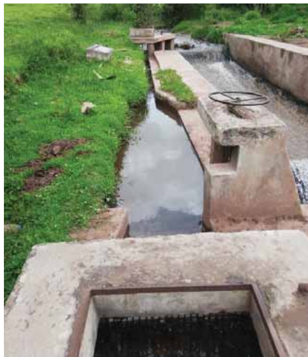
Fotografía 3. Captación N° 4 Chanchería
