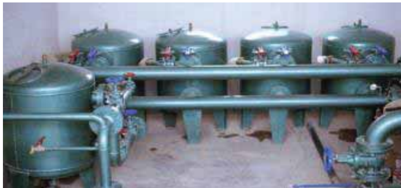
Figura 11. Filtro de Grava o Arena
