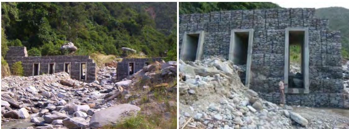
Ilustración 51. Presa Abierta Tipo Ventana, Fuente Presas Para El Control De Flujos Torrenciales En El Estado Vargas Venezuela
