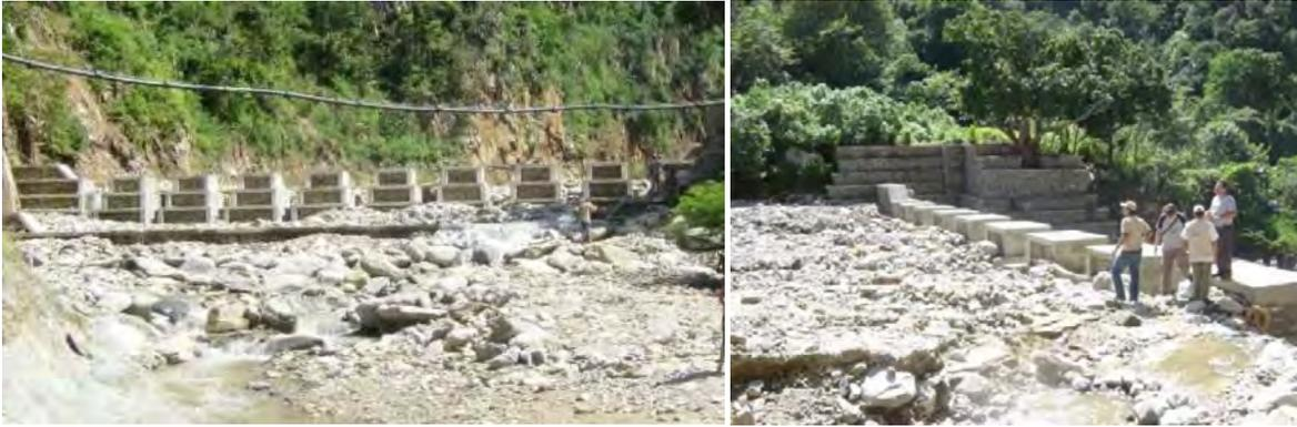
*Ilustración 52. Presa Abierta Tipo Ranura, Fuente Presas Para El Control De Flujos Torrenciales En El Estado Vargas Venezuela*
