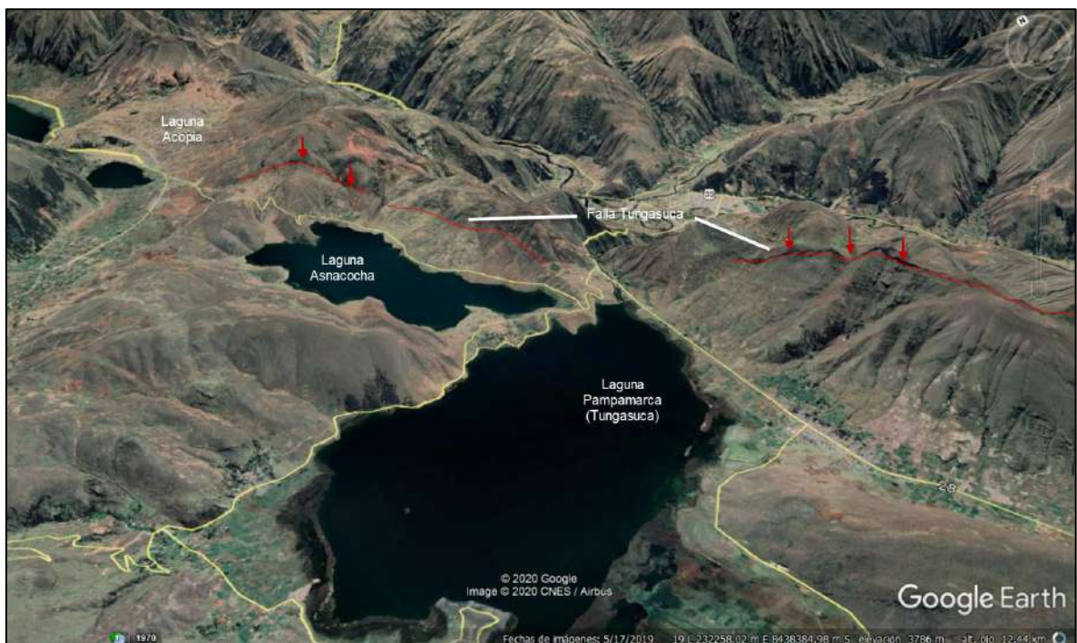
IMAGEN 16: IMAGEN 1: VISTA SATELITAL DE ESCARPES DE LA FALLA TUNGASUCA, EL CUAL AFECTA LAS CAPAS DE LA FORMACION MURCO Y ARCURQUINA.
