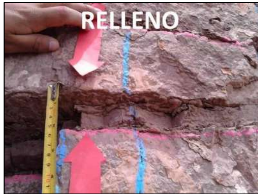
FOTOGRAFÍA 43: IDENTIFICACION DEL RELLENO EN LAS DISCONTINUIDADES.
