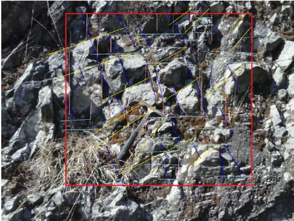
FOTOGRAFÍA 46: VENTANA ESTRUCTURAL EN MACIZO ROCOSO DE LA FORMACION ARCUQUINA
