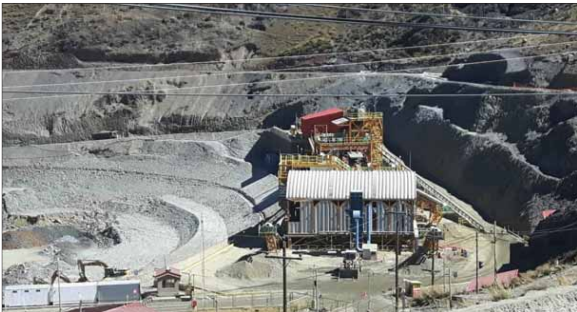
Figura 3.25: Pilas de evacuación - Planta de Pre Concentrado
