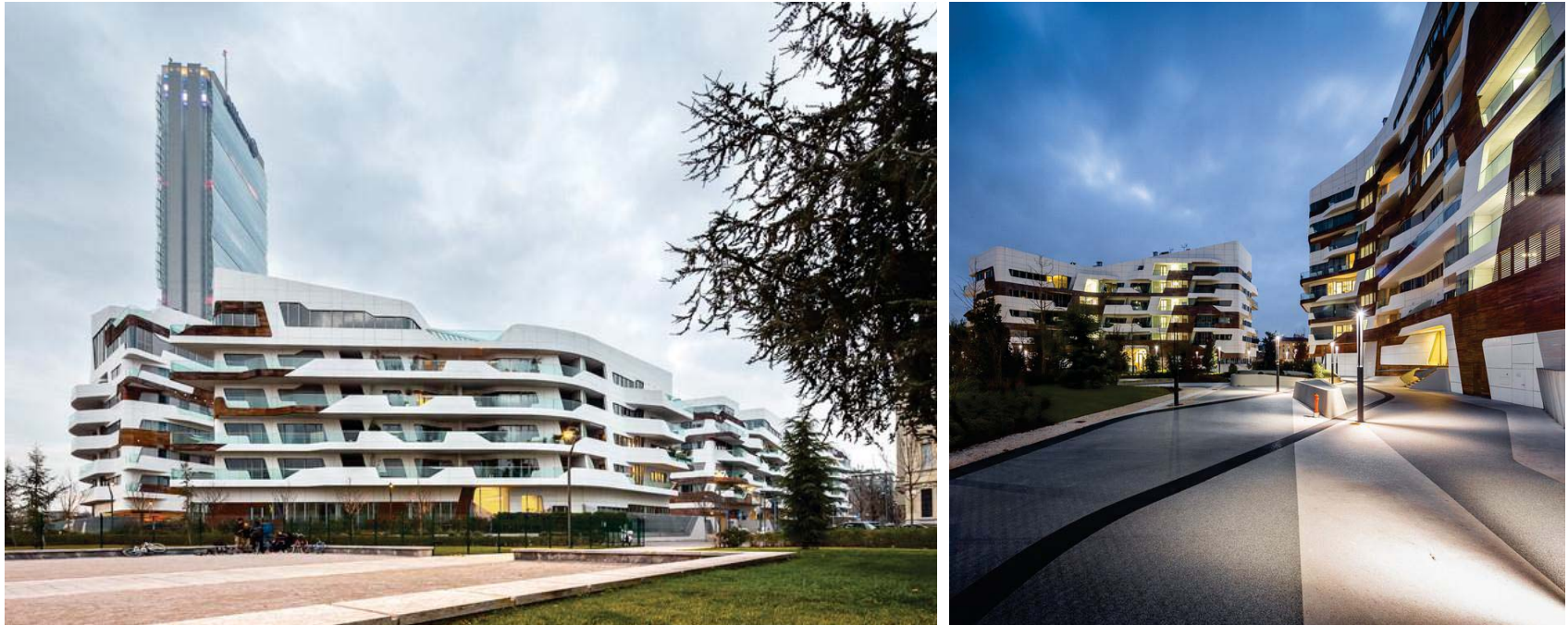
Figura 42: Vista fachadas del complejo residencial.
