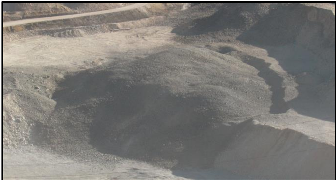
Figura 4.22: Post Voladura - Proyecto 1-01-3765-011
