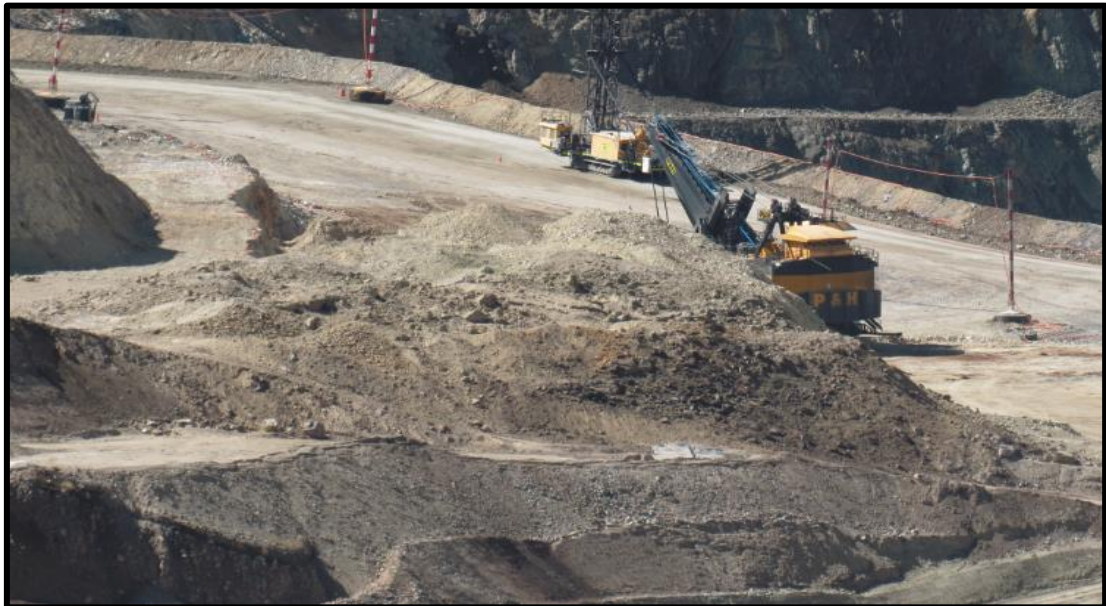
Figura 4.31: Pre Voladura Proyecto 1-01-3900-055
