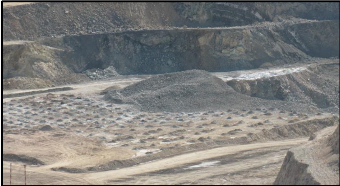
Figura 4.24: Pre Voladura - Proyecto 1-01-3855-019-020
