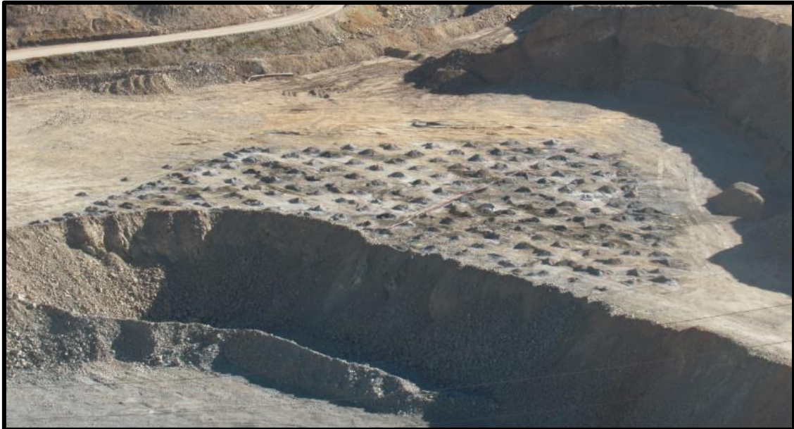
Figura 4.21: Pre Voladura - Proyecto 1-01-3765-011
