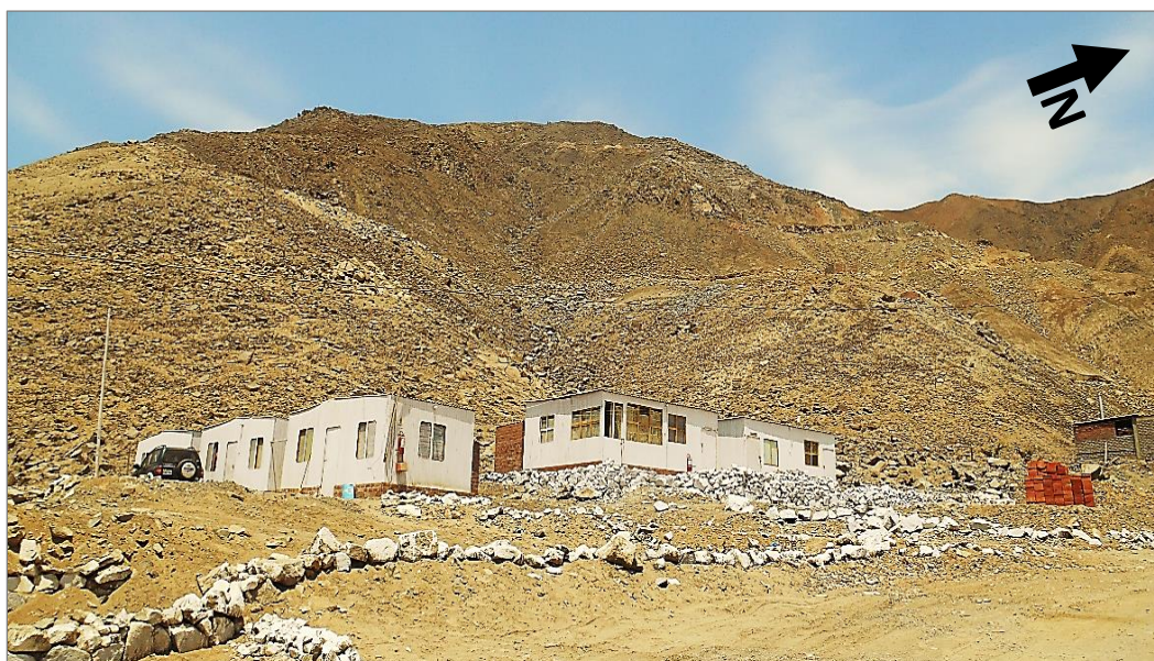
Foto 11: El campamento Phoenix-5 está construido sobre los depósitos aluviales.
