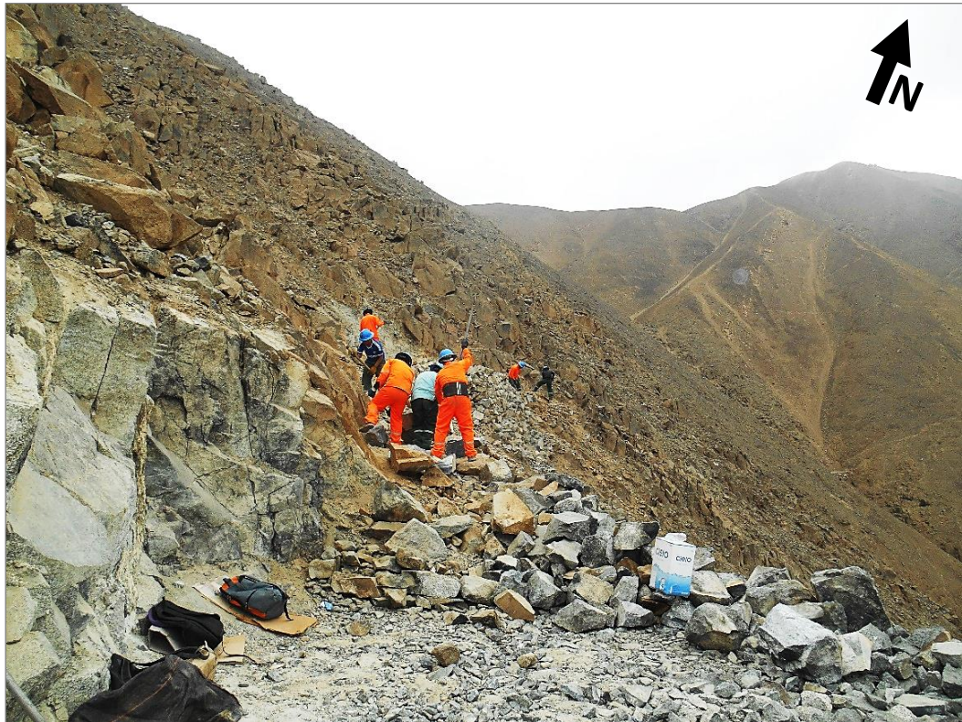
Foto 15: Superficie, afloramiento de la diorita Phx-5 con más de 3 sistemas de juntas.
