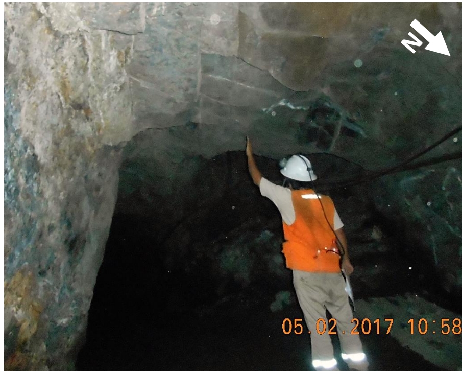
Foto 35: Interior mina, SN-243, GA-248, se observa la zona de falla de San Jerónimo presentando hacia su piso un sistema de juntas paralelo a la estructura principal, con relleno de calcita, óxidos de hierro y gouge.
