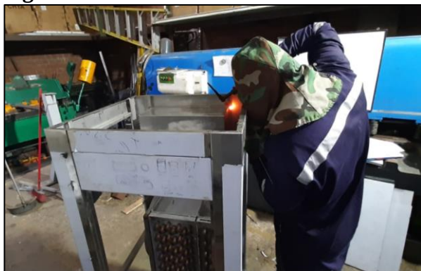
Figura 4-8 Soldado de la estructura metálica con proceso de soldadura TIG (GTAW)
