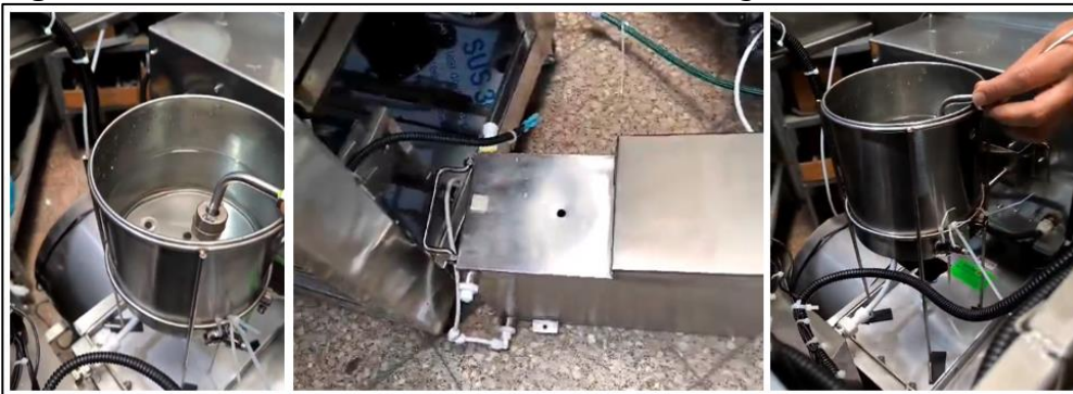
Figura 4-16 Pruebas del sistema de tratamiento de agua
