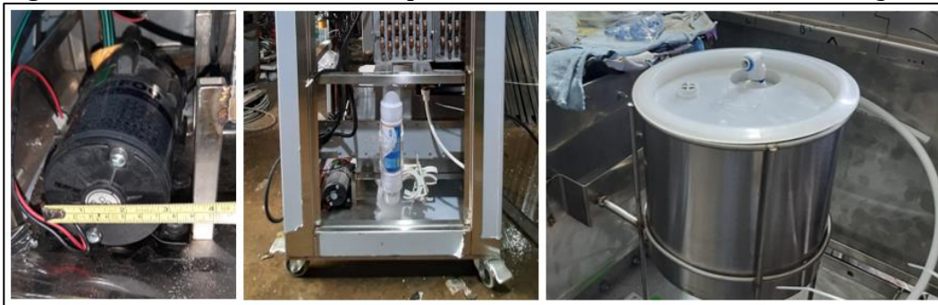
Figura 4-15 Instalación de los componentes del sistema de tratamiento de agua
