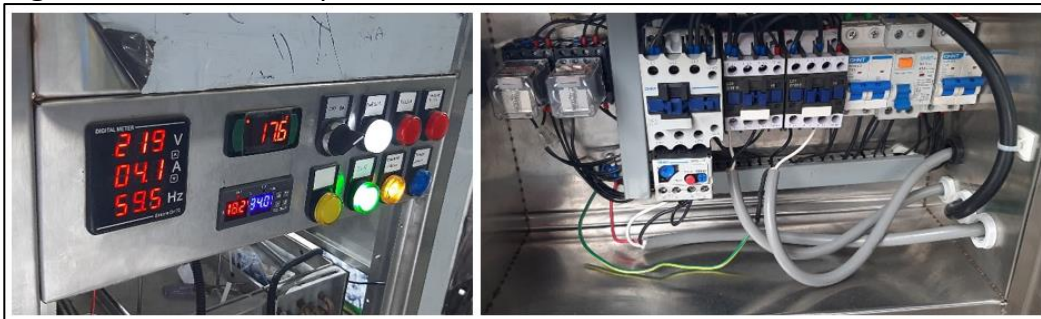
Figura 4-19 Pruebas de funcionamiento del sistema eléctrico
