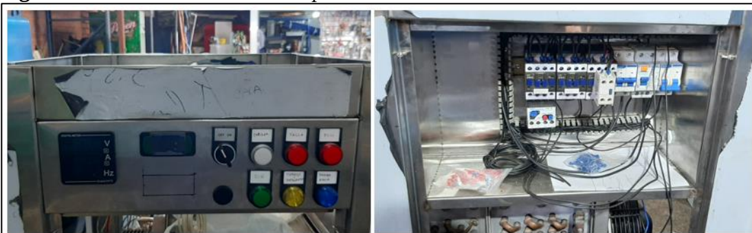
Figura 4-17 Instalación de los componentes del sistema eléctrico
