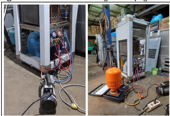
Figura 4-12 Proceso de carga de refrigerante
