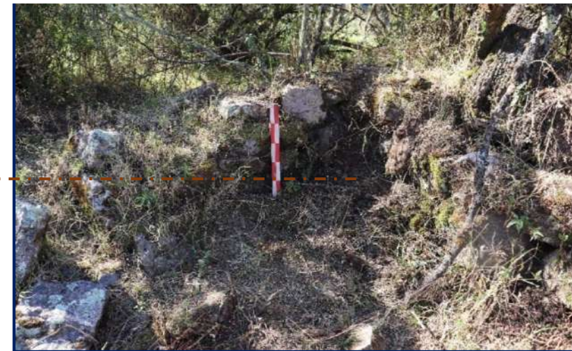
Paramento interior del muro frontal y lateral izquierdo de la UA-5
