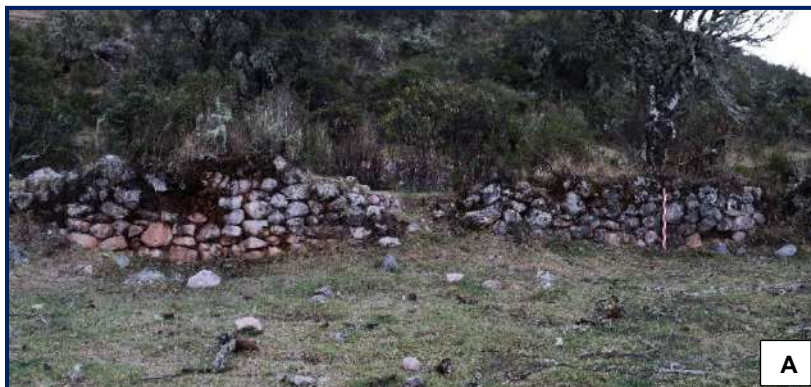
A.- Vista del muro perimétrico (lado Noroeste) – sector “A”.
