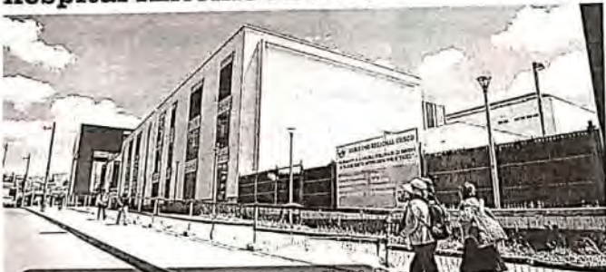
Convenio comprende el mejoramiento y culminación del Hospital Antonio Lorena del Cusco.
