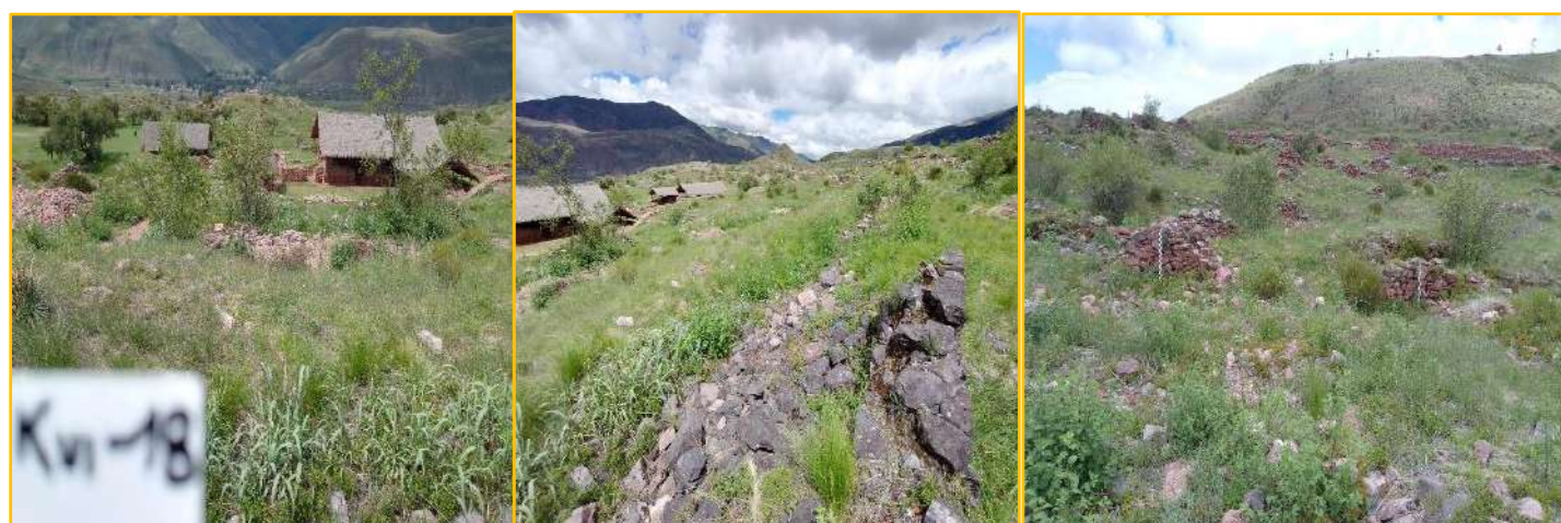
Figura 32 Fotografías del estado de conservación, Kancha 18.
