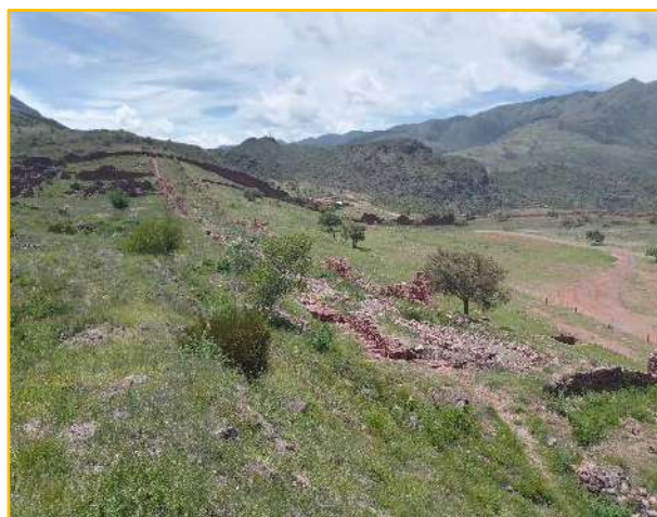
Figura 86 Fotografías del estado de conservación Kancha 76
