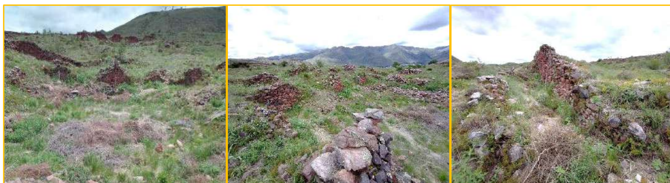
Figura 77 Fotografías del estado de conservación, Kancha 44
