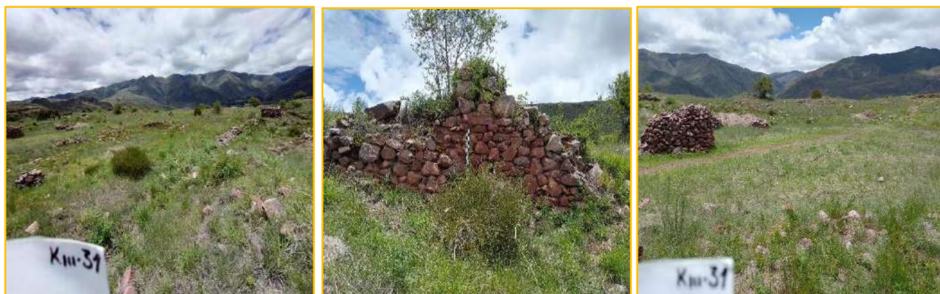
Figura 75 Fotografías del estado de conservación, Kancha 31
