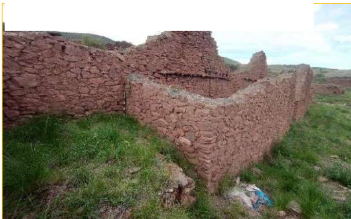
Paramento Norte, muestra intervención
