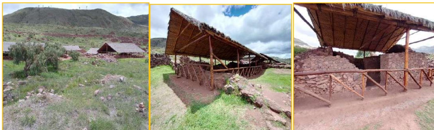
Figura 63 Fotografías del estado de conservación, Kancha 32
