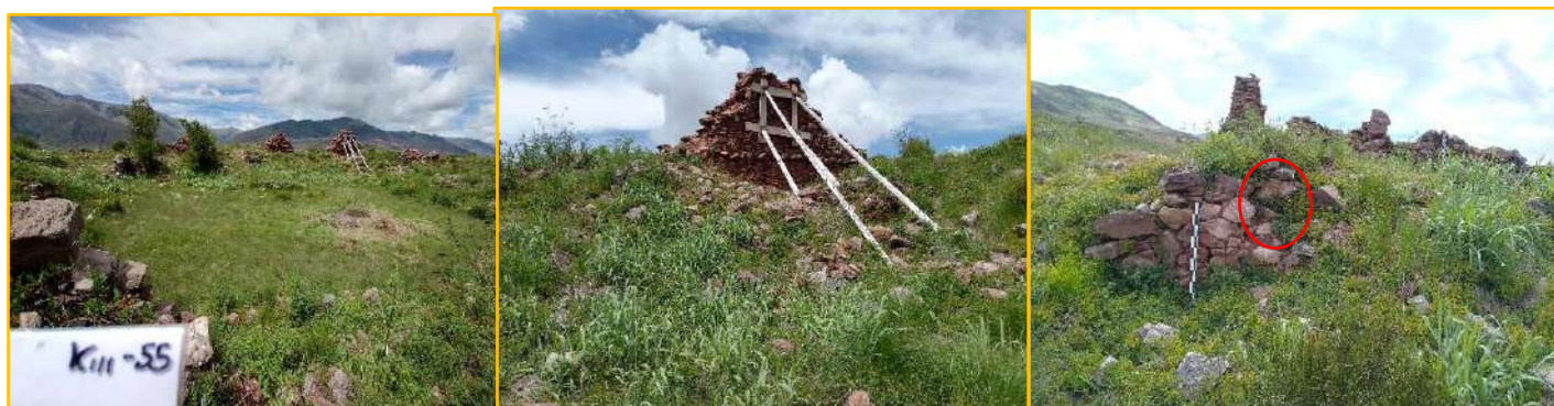
Figura 69 Fotografías del estado de conservación, Kancha 55
