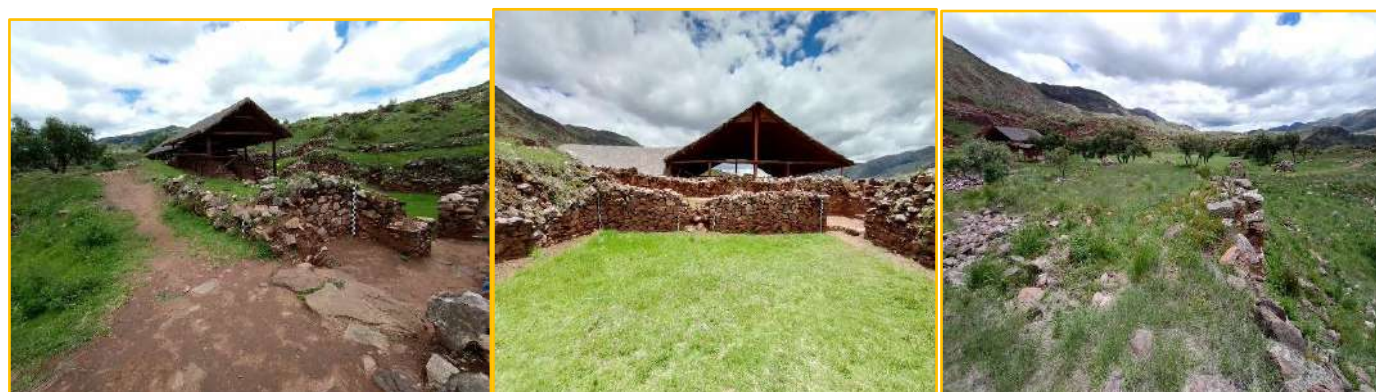
Figura 64 Fotografías del estado de conservación, Plaza Kancha
