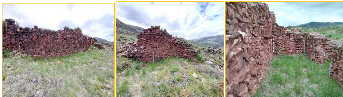
Figura 73 Fotografías del estado de conservación, Kancha 29
