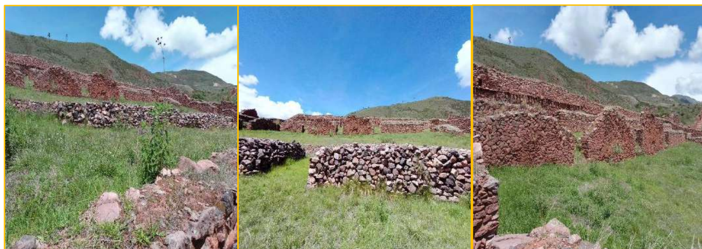
Figura 31 Fotografías del estado de conservación, Kancha 08.
