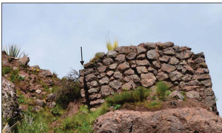
Foto N° 58: Vano de acceso de doble jamba en el recinto 01.
