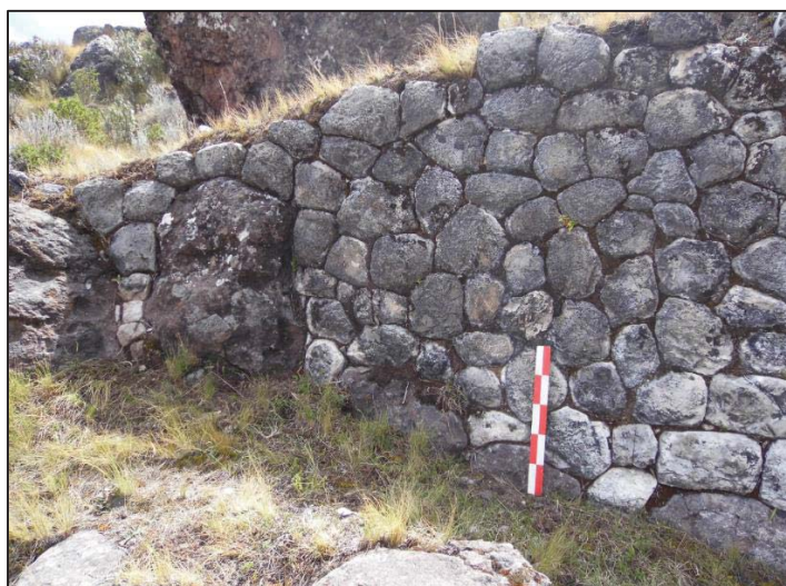
Foto N° 83: Aparejo celular en el muro de contención 05.
