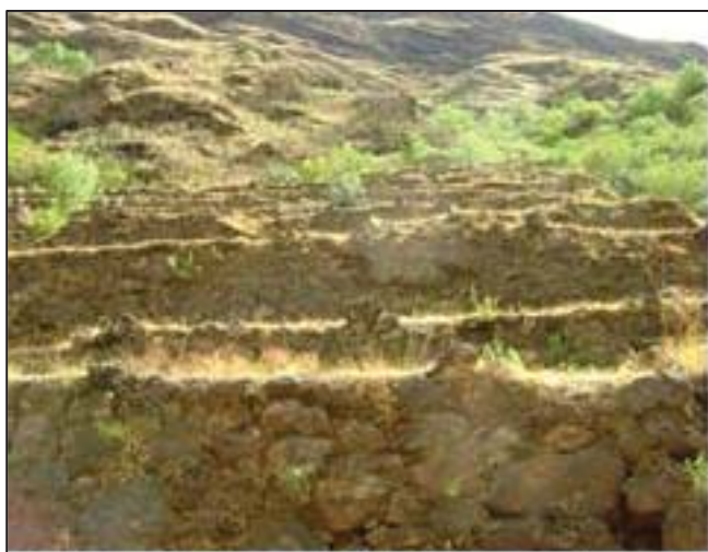
Foto N° 71: Izquierda: Muros de contención que soportan andenes en Qaswa. Fuente: (Laurel Paucar, 2012); Derecha: Muro de contención 08 de Chuncal que soportan plataformas. Fuente: (Rado Aguilar & Espinoza Cruz)
