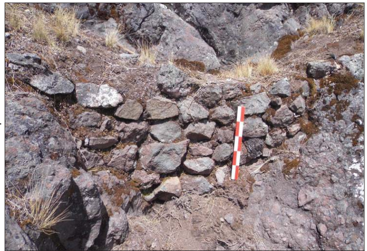
Imagen N° 32: Muro de contención 04. Fuente: (Rado Aguilar & Espinoza Cruz)
