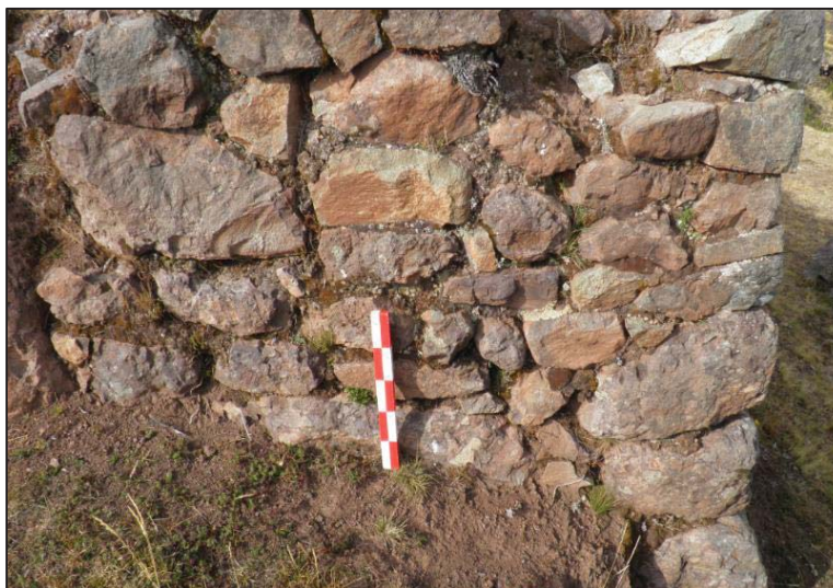
Foto N° 86: Recinto 04 se observa el mortero utilizado para unir los elementos líticos. Fuente: (Rado Aguilar & Espinoza Cruz)
