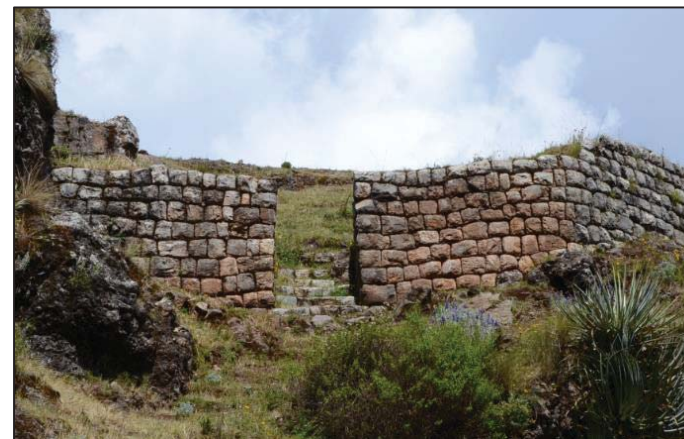
VANO DE ACCESO 01
