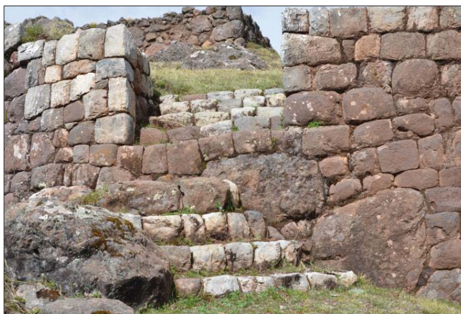
VANO DE ACCESO 03
