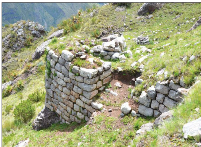
VANO DE ACCESO 02
