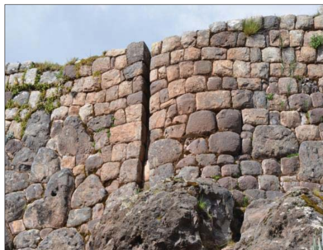
Foto N° 71: Izquierda: Muros de contención que soportan andenes en Qaswa. Fuente: (Laurel Paucar, 2012); Derecha: Muro de contención 08 de Chuncal que soportan plataformas. Fuente: (Rado Aguilar & Espinoza Cruz)
