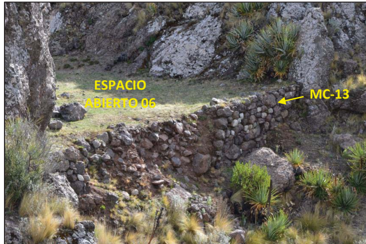
Foto N° 76: Muro de contención que sostiene un espacio abierto.
