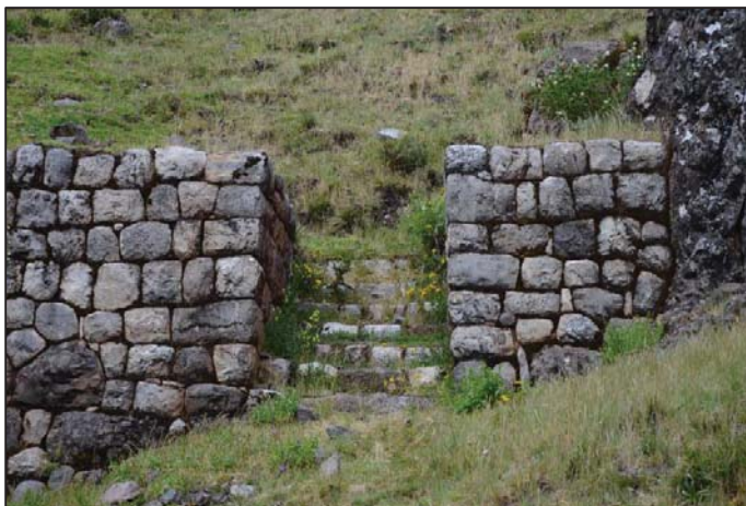
VANO DE ACCESO 02
