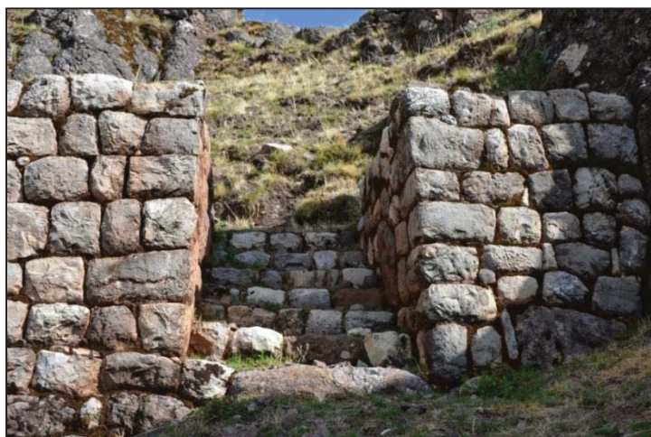
Foto N° 59: Vano de acceso 02 del muro de contención 08.
