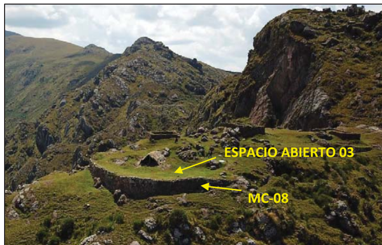
Foto N° 77: Muro curvo que sostiene un espacio abierto.
