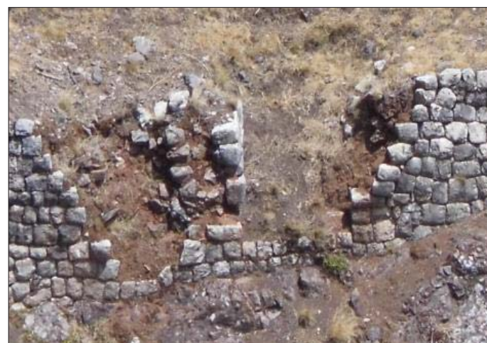
VANO DE ACCESO 01
