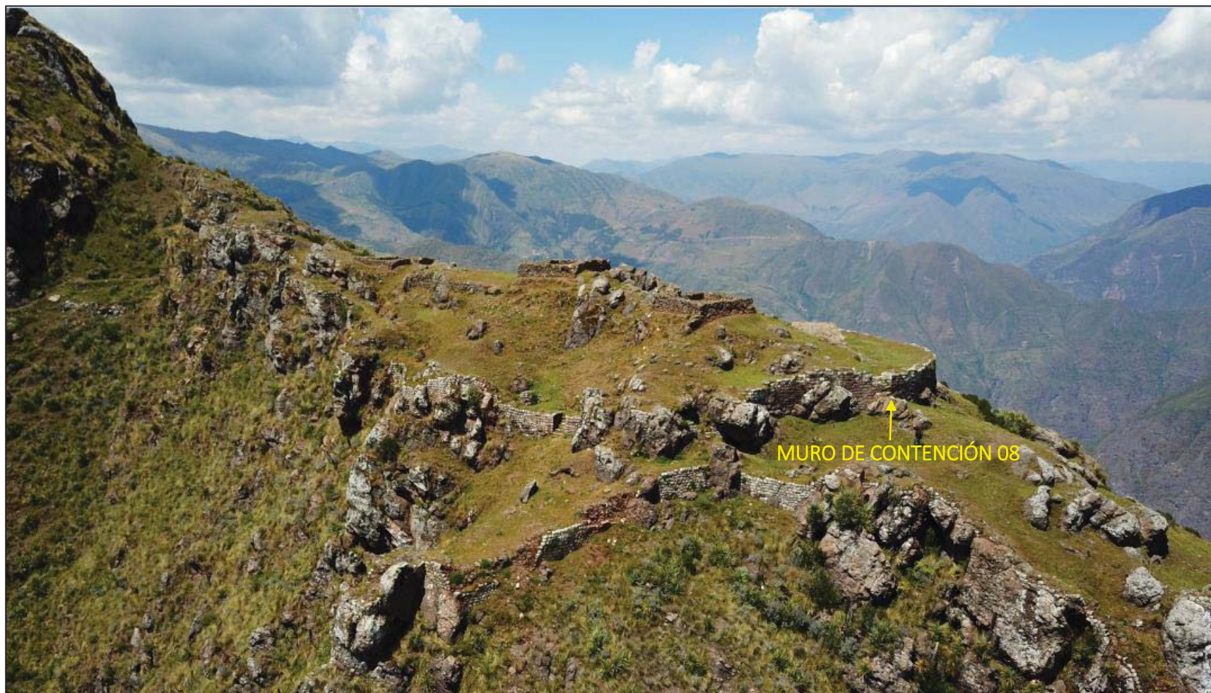
Foto N° 44: Panorámica del Muro de Contención 08, tomada con Drone desde el Sector III. Fuente: (Rado Aguilar & Espinoza Cruz)
