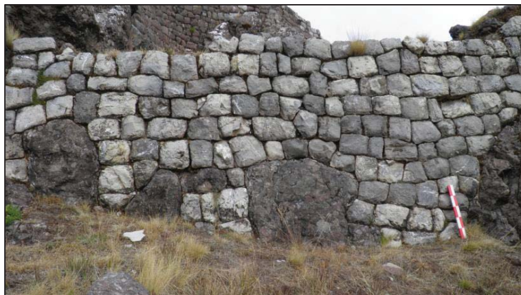
Foto N° 81: Muro de contención 13 construido con conglomerados y caliza.
