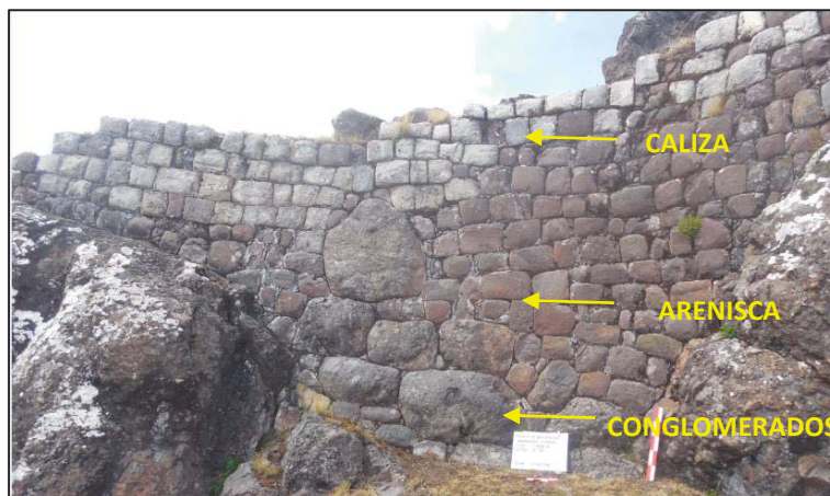
Foto N° 82: Muro curvo construido con conglomerados, arenisca y caliza.
