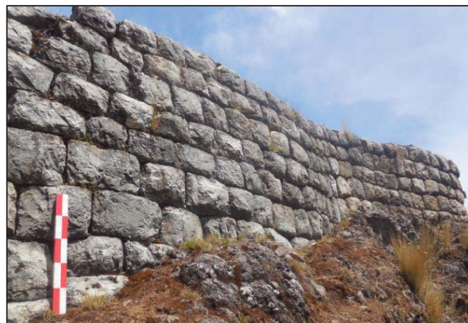
Foto N° 56: Muro de Contención 08 de aparejo sedimentario. Fuente: (Rado Aguilar & Espinoza Cruz)
