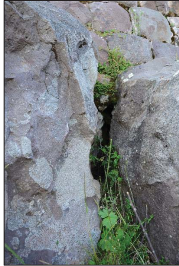
Foto N° 62: Canal de drenaje.
