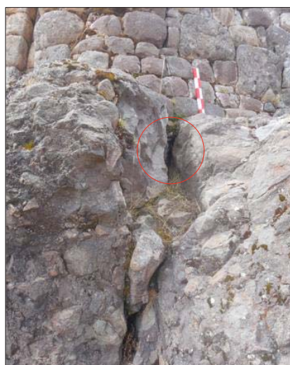
Imagen N° 40: Canales verticales y canal de drenaje del muro de contención 08.
