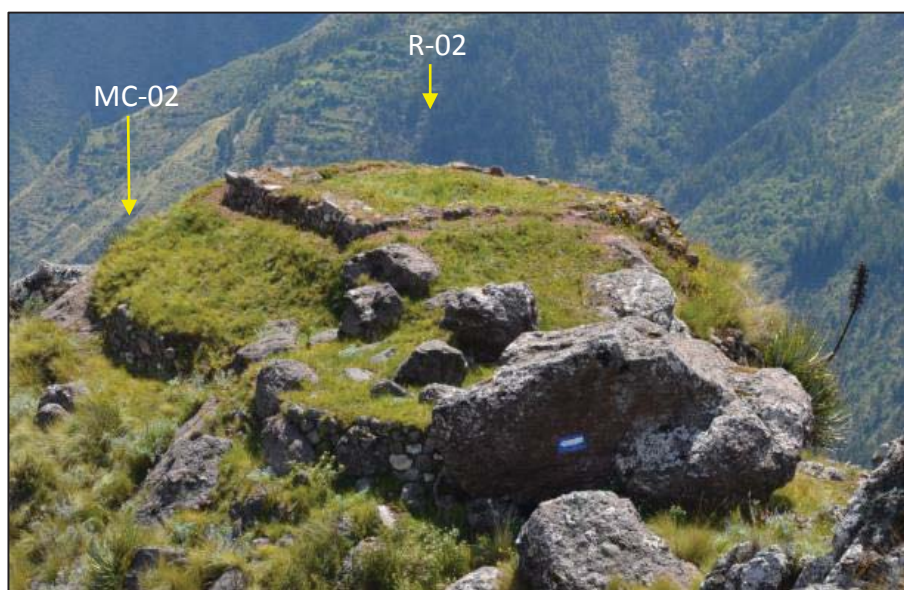
Foto N° 37: Muro de Contención 02, sostiene la plataforma donde se ha construido el Recinto 02. Fuente: (Rado Aguilar & Espinoza Cruz)
