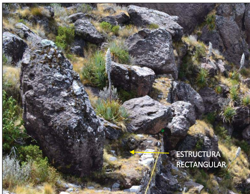
Foto N° 41: Estructura rectangular formada por dos muretes acoplados al Muro de contención 05. Fuente: (Rado Aguilar & Espinoza Cruz)
