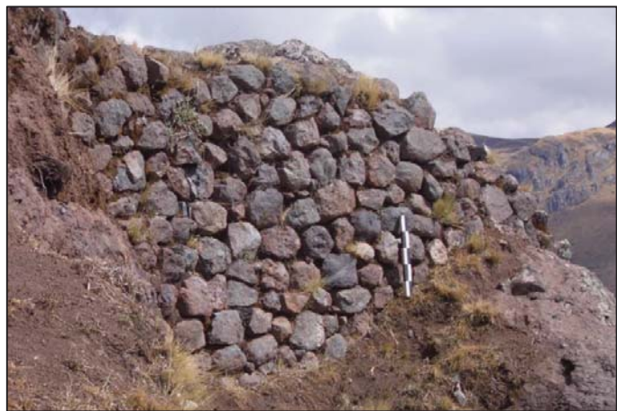
Foto N° 57: Muro de Contención 01 de aparejo simple. Fuente: (Rado Aguilar & Espinoza Cruz)
