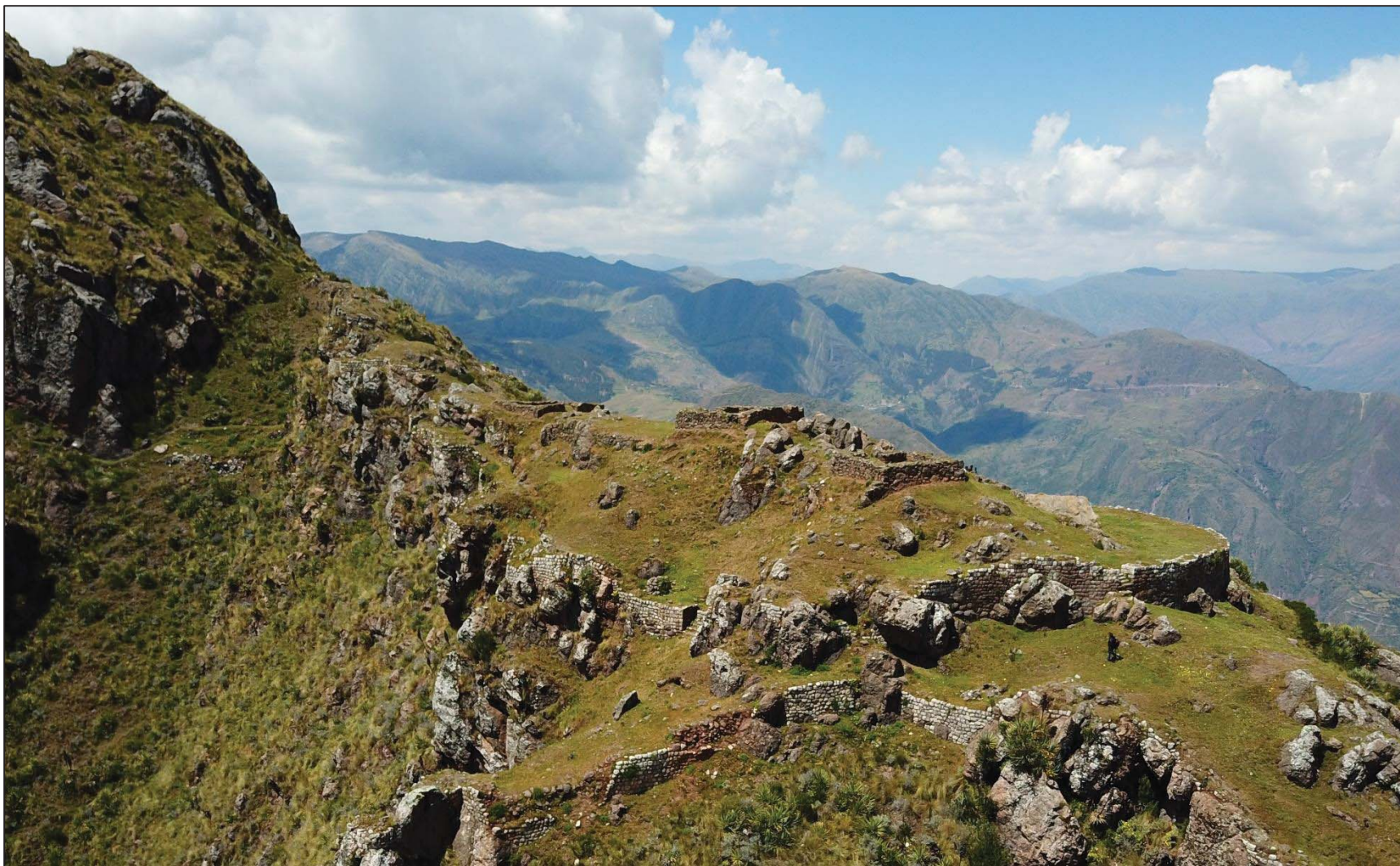
Foto N° 50: Panorámica del Muro de Contención 13 (Tramo Noroeste), tomada desde el Sector III.
