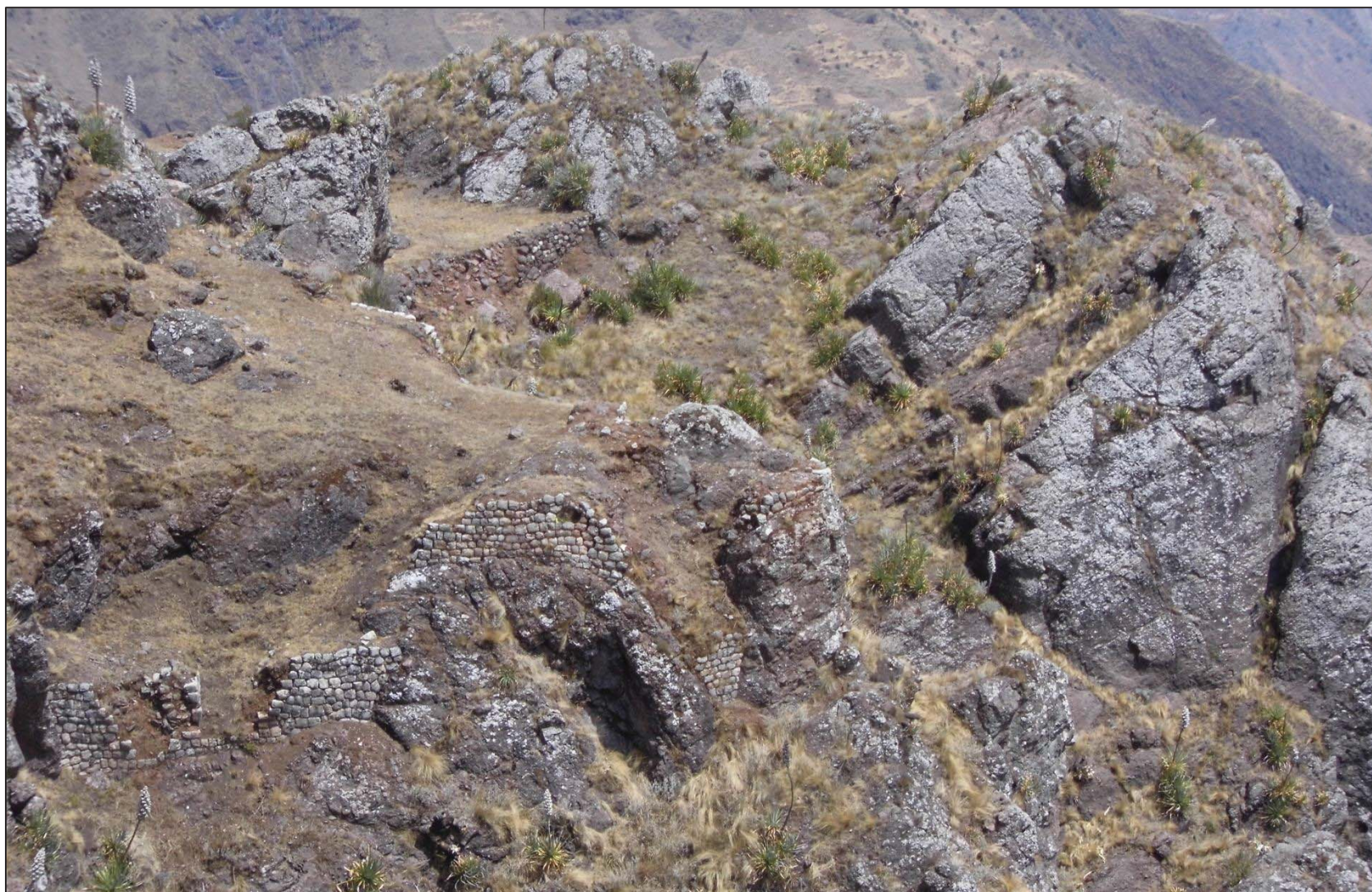
Foto N° 49: Panorámica del Muro de Contención 13 (Tramo Noreste), tomada desde el Sector I.
