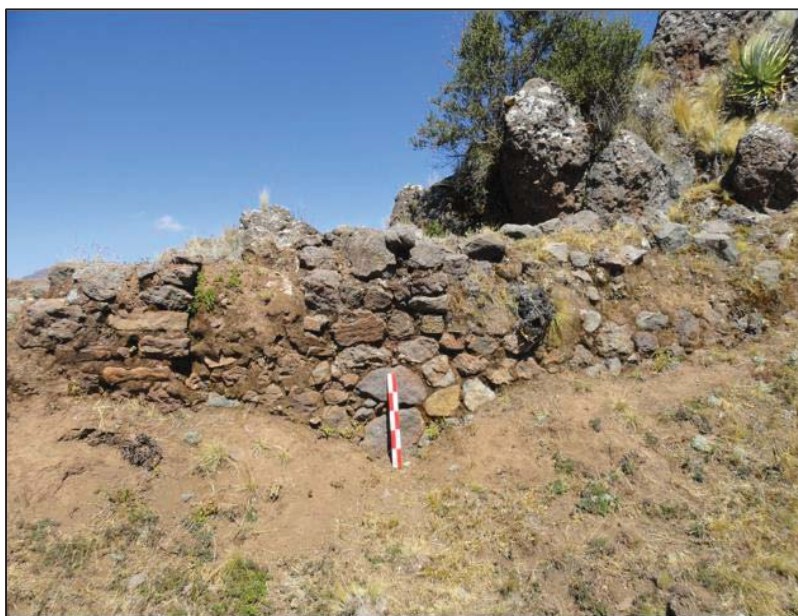
Foto N° 36: Muro Sur donde se observa los nichos en el Recinto 01.
