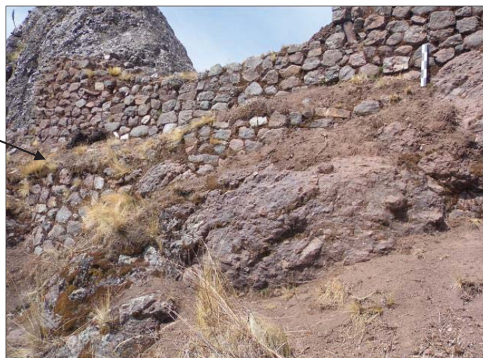
Imagen N° 29: Muro de Contención 03. Fuente: (Rado Aguilar & Espinoza Cruz)
