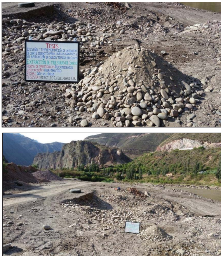
Figura 71 Imágenes de la cantera de Huambutio.
