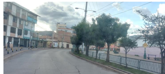
Figura 68 La vía expresa presenta pendientes de 1.35%
