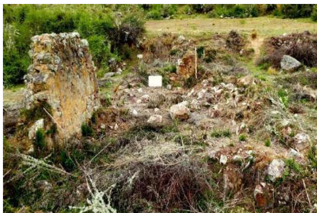
Elementos funcionales primarios (muros) de la estructura 11 - sector C
