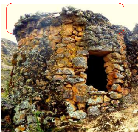
Nota. Presencia de cornisa.
