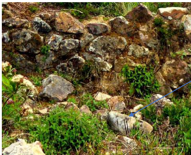
Muro Externo de la Estructura 01
