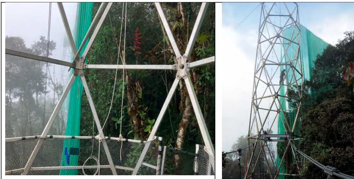
Vista de la estructura desde una de las torres en la parcela TRT-PH
