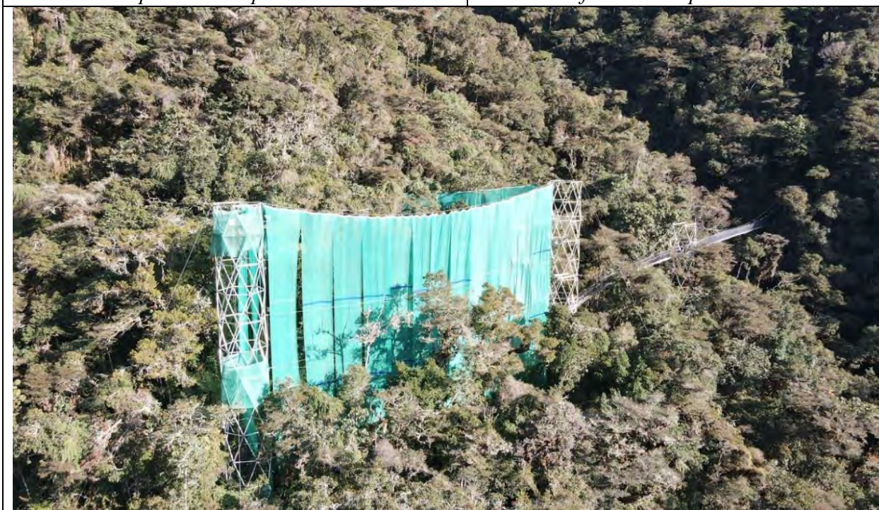
Parcela tratamiento de precipitación horizontal mostrando su condición estructural Fotografía cortesía de Scott Larotta, comunicación personal, 2024.
