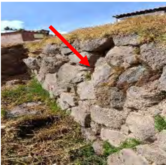
Fotografía 2 Daño en el primer andén-desplazamiento lateral
