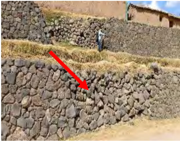
Fotografía 3 Muro con falta de mortero – Segundo y tercer andén
