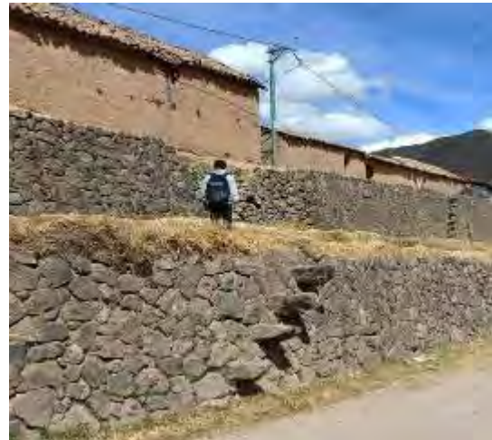
Fotografía 3 Muro con falta de mortero – Segundo y tercer andén
