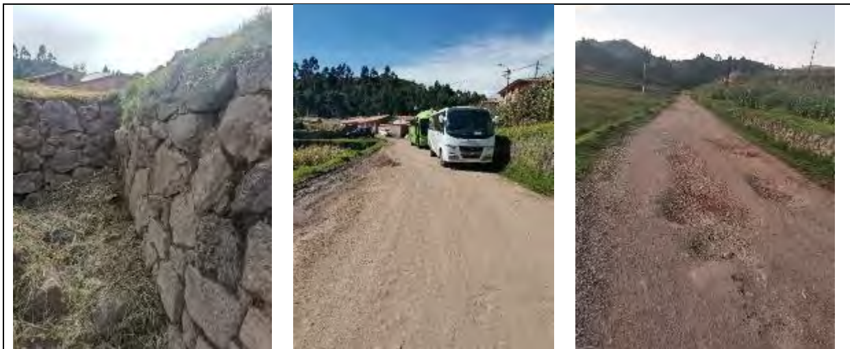
Fotografía 1 Mal estado de los andenes, se muestra signos de deterioro
