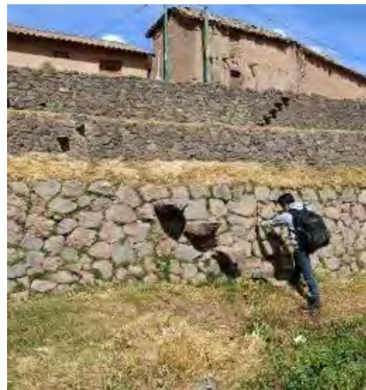
Fotografía 2 Daño en el primer andén-desplazamiento lateral
