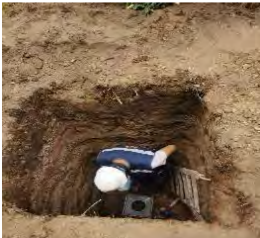
Fotografía 4 Excavación de calicatas
