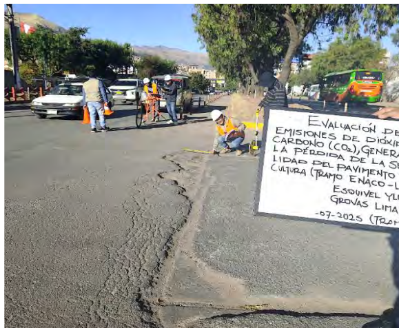
Personal de apoyo realizando la toma de datos con equipo MERLIN en el cuarto paradero.
