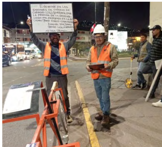
Finalización del levantamiento del IRI con equipo MERLIN en la plaza Limacpampa.
