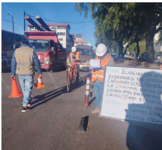
Medición de rugosidad con equipo MERLIN en el tramo, primer paradero – Hospital Regional.
