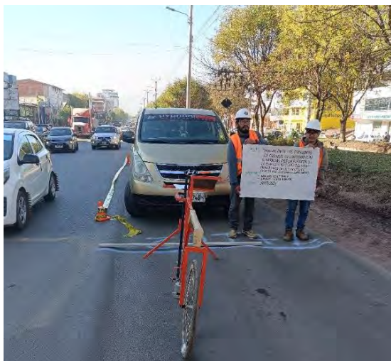
Progresiva inicial (7+200) en el paradero Enaco, estacionamiento y punto de inicio del estudio de IRI
