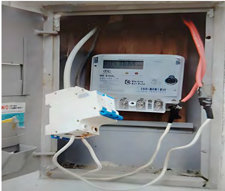
Figura 26 Medidor con Conexión Clandestina (Punteo)
