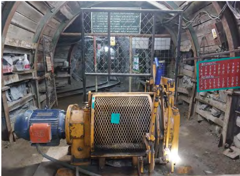
Ilustración 16. Winche de izaje nivel 480, zona Mercedes
