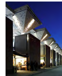
Figura n° 87: Vista iluminación exterior FUENTE: https://www.google.com/search?q=mercado+de+tirso .
