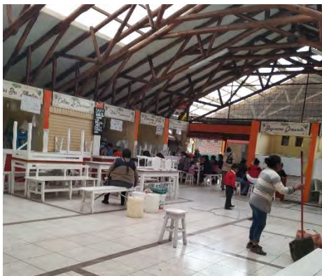
Figura N° 133: Zona de comidas (construcciones de concreto y cobertura con estructura de madera) FUENTE: propia (2019)
