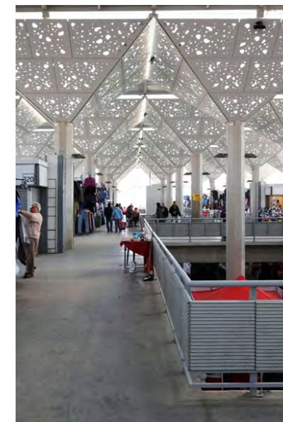
Figura n°85: vista interior estructura de techo Fuente: Plataforma arquitectura (2011). Mercado Tirso de Molina
