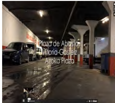
Figura n° 59: Vista de las columnas en estacionamiento FUENTE: https://www.floornature.es
