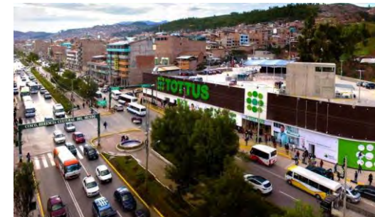
Figura N° 32: Vista general Supermercado Tottus FUENTE: https://www.peru-retail.com/
