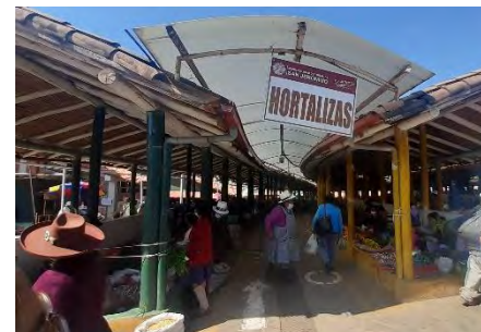
Foto N° 166 - 167: Área de venta de Verduras y frutas, construida con madera rolliza con cobertura de fibrocemento. Material presente en casi la totalidad del Mercado Vinocanchon. FUENTE: propia (2019)
