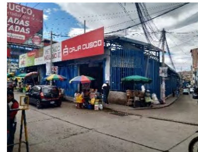
Figura N° 20: Fachada principal Mercado el Molino II
