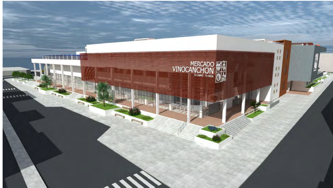
VISTA DE LA FACHADA FRONTAL UBICADA EN LA ESQUINA DE LA AV. RAMON CASTILLA Y CA. CLORINDA MATTO DE T.)
