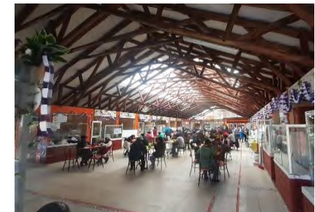
Foto N° 164 - 165: Vista del área de comidas construida en su totalidad de concreto armado y con cobertura de fibrocemento (teja andina) sobre estructura de madera FUENTE: propia (2019)
