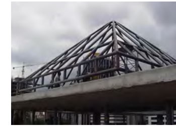
Figura n° 77 y 78: Vista de la losa macisa y estructura metálica del ducto iluminación FUENTE: https://www.floornature.es
