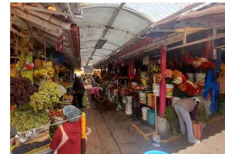
Foto N° 166 - 167: Área de venta de Verduras y frutas, construida con madera rolliza con cobertura de fibrocemento. Material presente en casi la totalidad del Mercado Vinocanchon. FUENTE: propia (2019)
