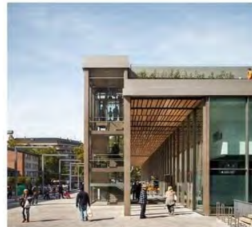
Figura n° 60: Vista de columnas que conforman la galería a doble altura FUENTE: https://www.floornature.es
