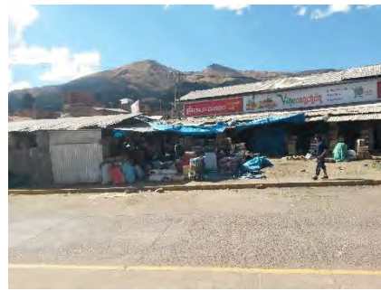
Figura N° 05: Áreas exteriores usadas como depósitos Fuente: Propia (2019)
