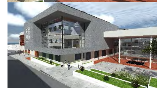
Imagen N° 233-240: Vista Interior y exterior del Mercado de Abastos Vinocanchon Fuente: Propia (2023).
