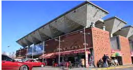
Figura n° 91: Vista de estructura de techo del edificio FUENTE: https://www.floornature.es
