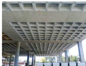
Foto N° 260-164: Vista interior losa nervada y losa maciza FUENTE: plataforma arquitectónica.com.pe
