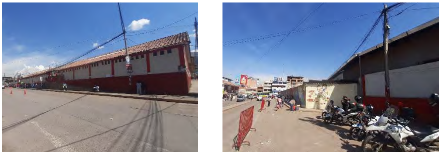
Foto N° 170 - 171: los cercos perimetrales de todo el mercado cuentan con cerramientos de ladrillo y puertas metálicas.
