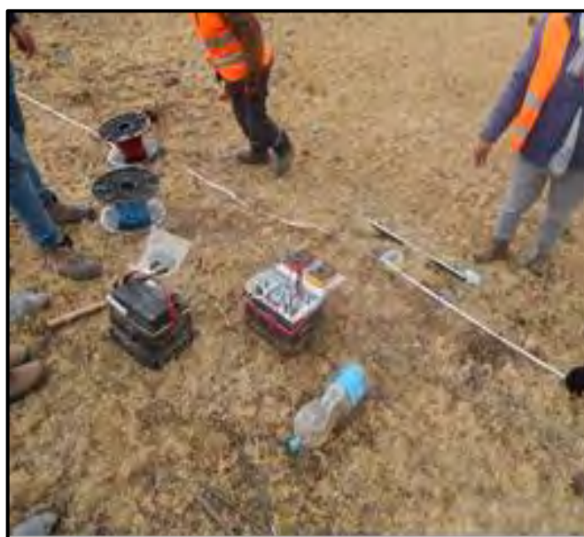
Figura 50 Instalación y medición de la resistividad del suelo
