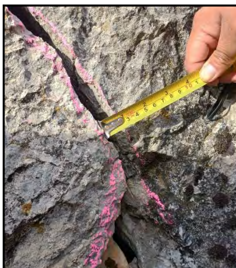
Figura 33 Afloramientos de calizas fracturadas y karstificadas
