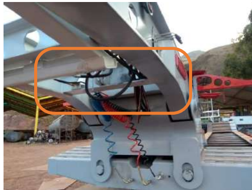
Figura 3.40: ubicación de los puentes transversales en el cuello desmontable. (FUENTE: propia)
