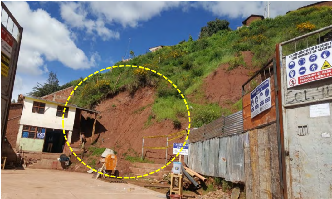
Nota. Se aprecia un proceso de erosión de laderas en la 05_ZRE
