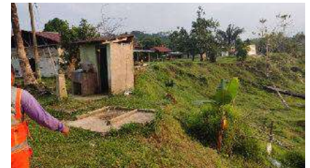
SECTOR CRÍTICO DE RIESGO SCR-2
