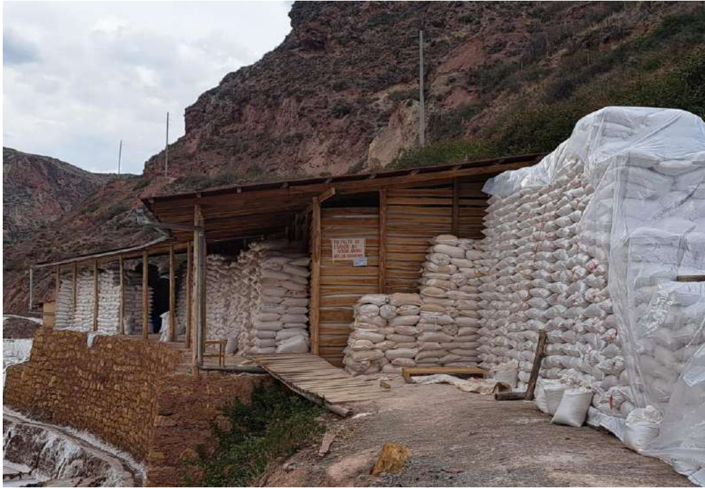
Fotografía 36. Tercer Almacén de la Empresa Marasal
