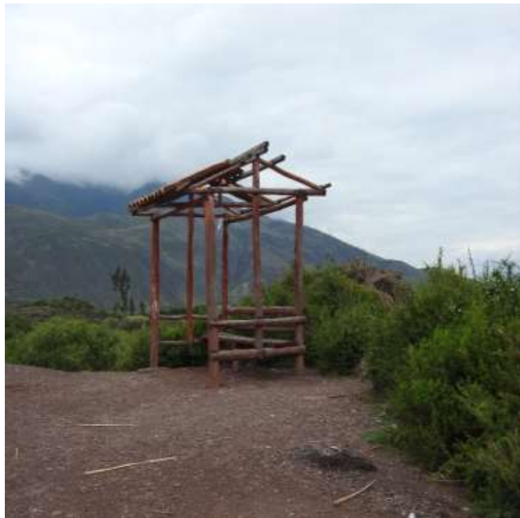
Mal estado de las instalaciones turísticas (paradores, miradores y senderos)
