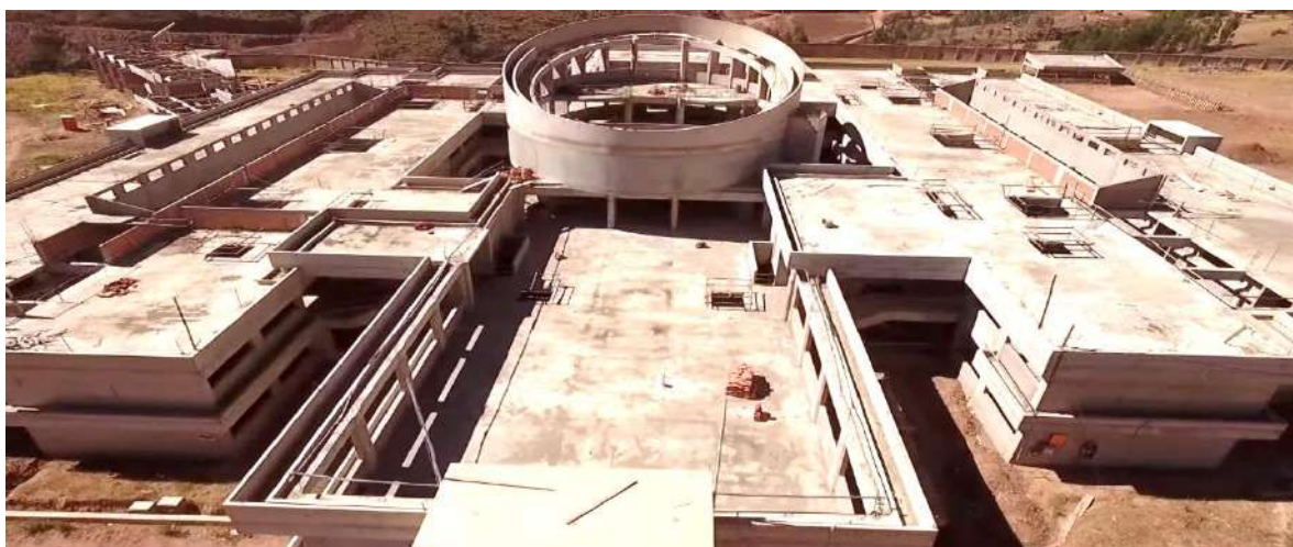
Figura 54. Imágenes del colegio la salle en construcción.
