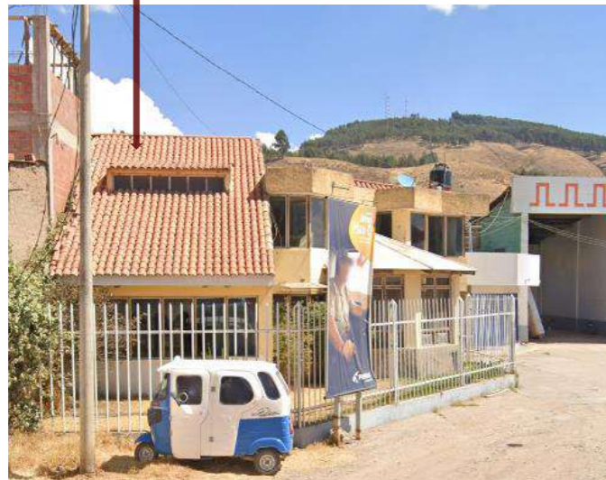
Imagen 163 Cubierta inclinada de un tramo
