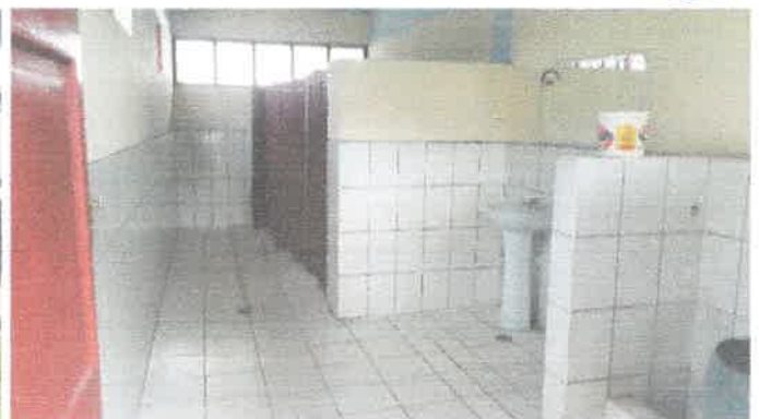
Fotografía 32.- SS.HH. en estado de conservación buena.
