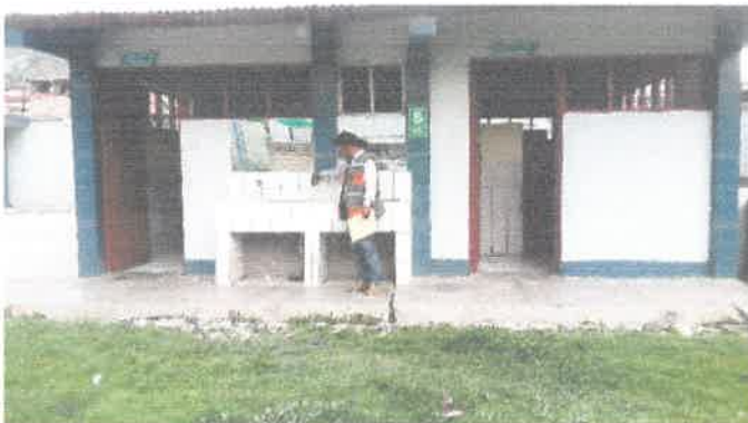
Fotografía 31.- Vista frontal de los SS.HH.
