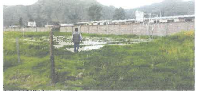
Fotografía 21.- se observa la vista frontal de la loza deportiva que requiere mantenimiento general.
