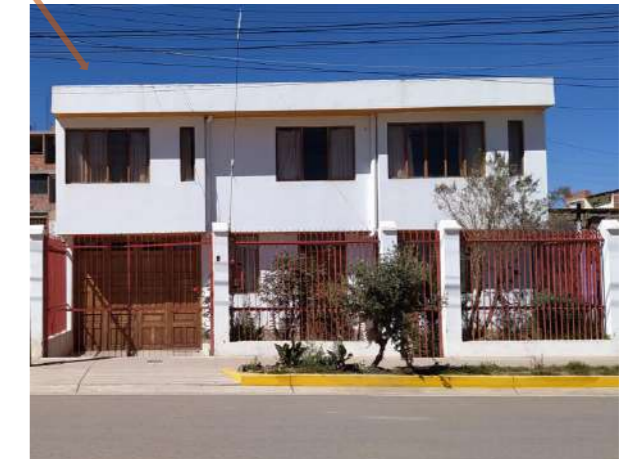
Imagen 162 Vista frontal – vivienda
