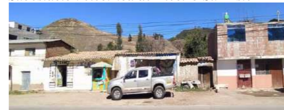
Imagen 51 Subestación eléctrica de Electro Sur Este
