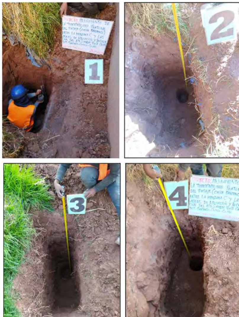
Figura 4.3 Exploración a Cielo Abierto - Calicatas
