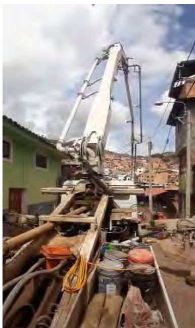
Figura 6.13 Vaciado de Concreto en Muros de Contención en Voladizos
