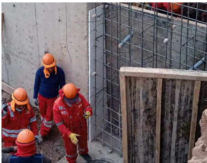
Figura 6.14 Procedimiento de Junta en Muros en Voladizos con teknoport e=1"
