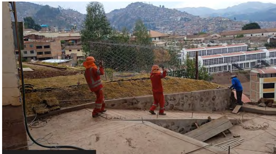
Figura 6.8 Procedimiento de Enmallado de Gaviones
