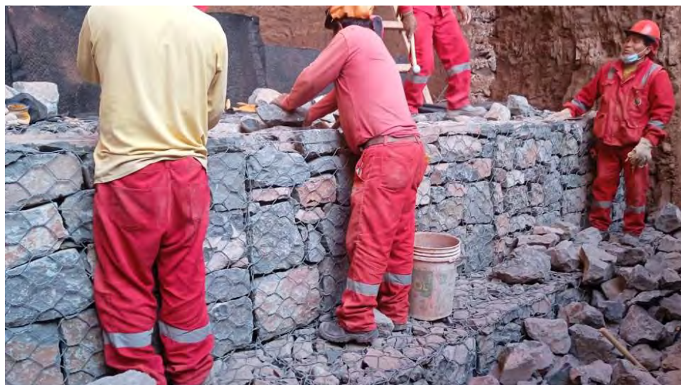
Figura 6.9 Armado y relleno con Piedras del Elemento Gavión Caja
