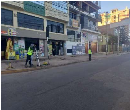
Vista lateral de los operadores en el cuarto tramo de la avenida Collasuyo -progresiva: 1+279 km
