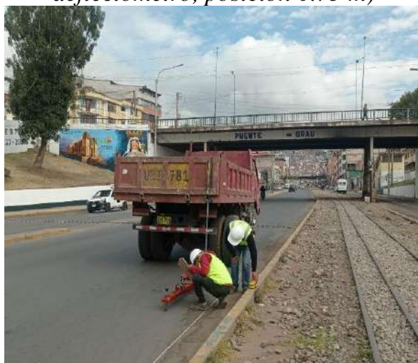
AV. Del Ejercito (lectura tomada del deflectometro, puente Grau 0.00 m)
