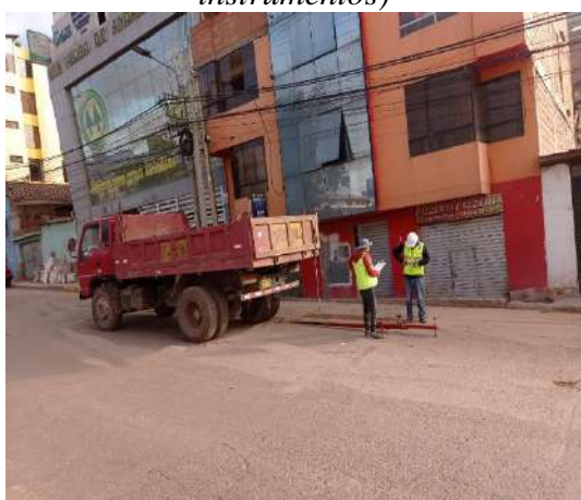
AV. Collasuyo (lectura tomada del deflectometro 0.25 m))
