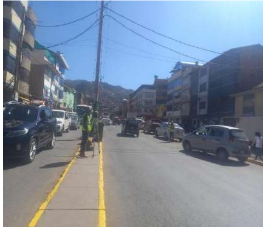
Vista lateral de los operadores en el segundo tramo de la avenida del Ejercito -progresiva: 0+709 km
