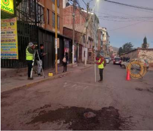
Vista lateral de los operadores tanto con el nivel y la mira en el final del cuarto tramo de la Av. Collasuyo -progresiva: 1+599 km
