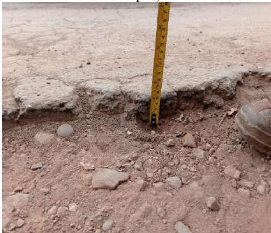
AV. Collasuyo (altura de la carpeta de rodadura 5cm)
