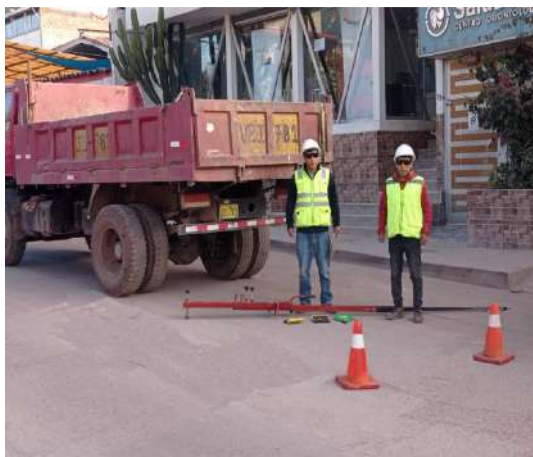
AV. Collasuyo (inicio de trabajo, instrumentos)
