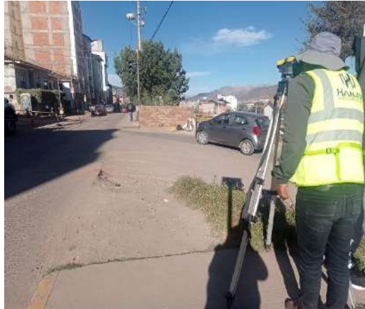
Vista lateral del operador del nivel de ingeniero en el tercer tramo de la avenida Collasuyo -progresiva: 0+861 km
