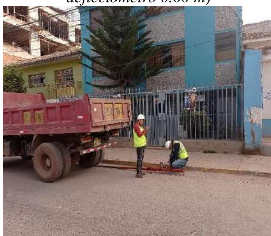
AV. Collasuyo (lectura tomada del deflectometro, Usaac 0.00 m)
