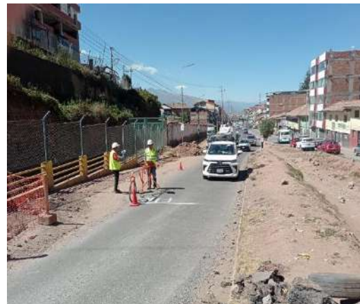
Toma de datos final del cuarto tramo de la avenida del Ejercito -progresiva: 1 + 600 km
