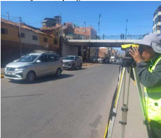
Vista lateral del operador del nivel de ingeniero en el tercer tramo de la avenida del Ejercito -progresiva: 1+019 km
