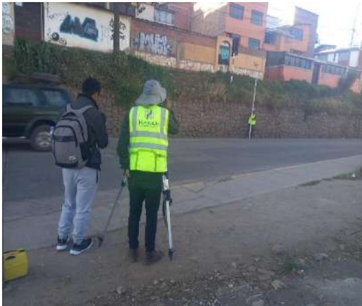
Vista posterior del operador del nivel, en el tercer tramo de la avenida Collasuyo -progresiva: 1+052 km
