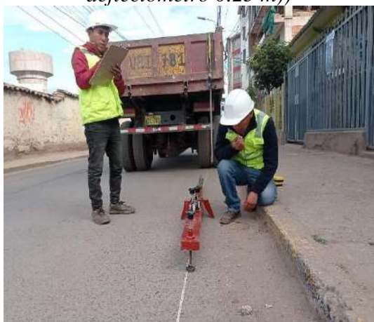
AV. Collasuyo (lectura tomada del deflectometro, detrás de la unsaac 1.00 m)
