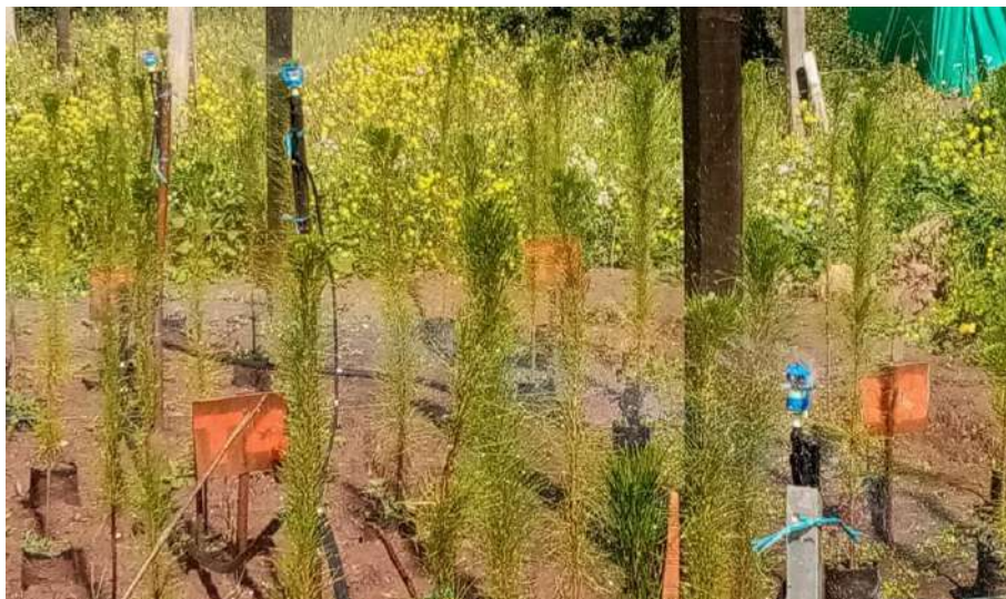
Fotografía 10: Instalación de microaspersores
